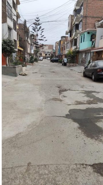
Figura N° 71 Terreno plano vista 1
