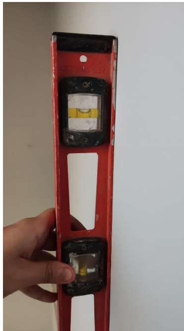
Figura N° 51 Verificación de verticalidad
