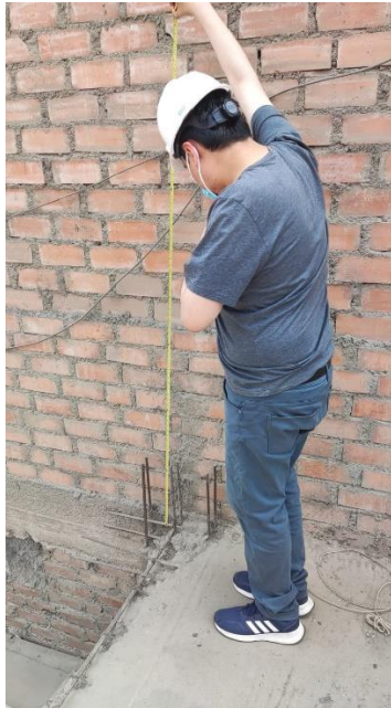
Figura N° 93 Cubierta no apoyada a la losa aligerada
