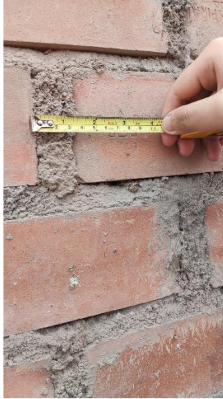
Figura N° 50 Junta de 1.50 cm
