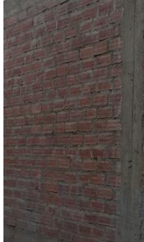
Figura N° 52 Ladrillo pandereta en muro portante
