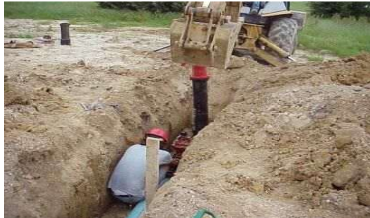
Figura 8: Trabajo de Excavacion Fuete: (OTI, 1996-2021)
