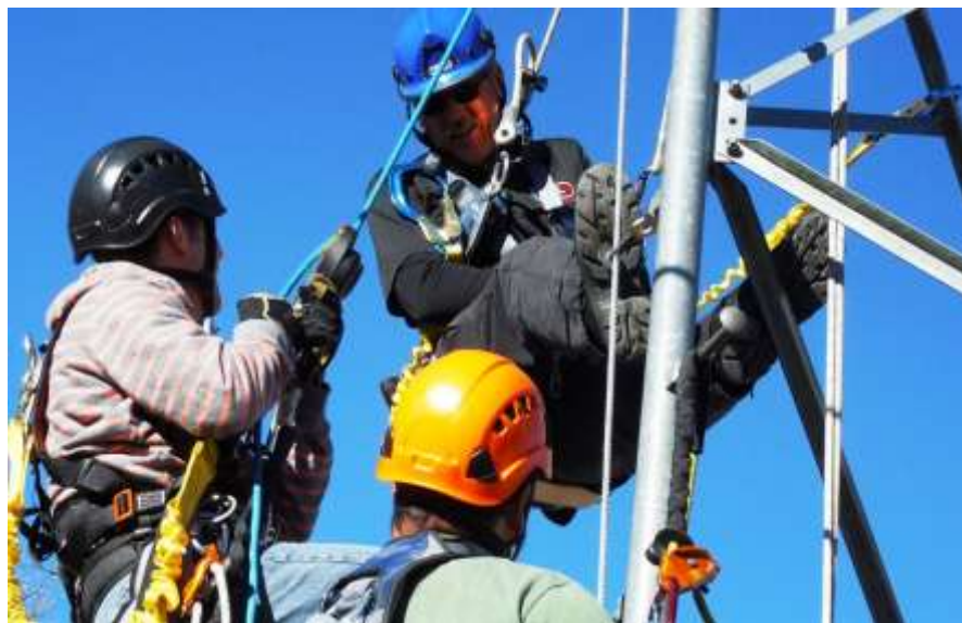
Figura 6: Trabajo en altura Fuete: (Trabajo en altura, s.f.)
