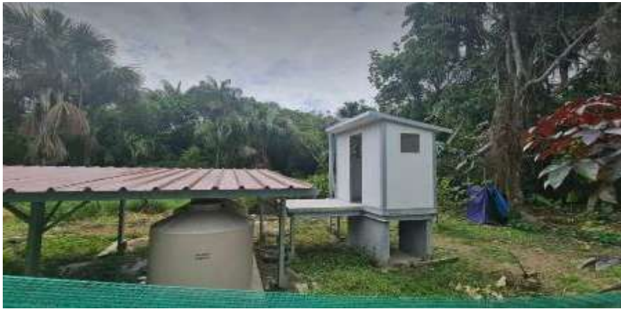
Figura 156 Vista de acabado de UBS con captación de agua pluvial en la localidad 13 de febrero Fuente: Elaboración propia
