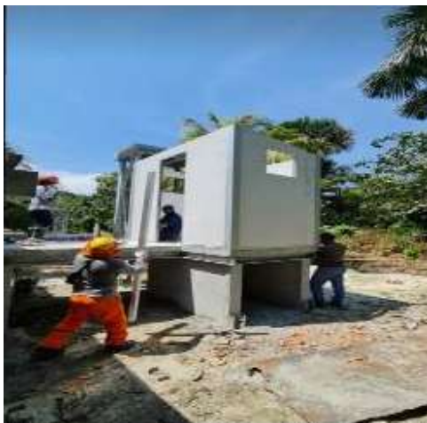
Figura 149 Colocación de Paneles de cobertura para modulo UBS en la localidad 13 de febrero
