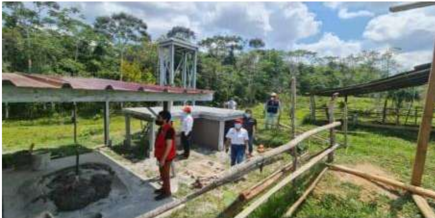
Figura 141 Losa de apoyo de almacenamiento de tanques cisternas.
