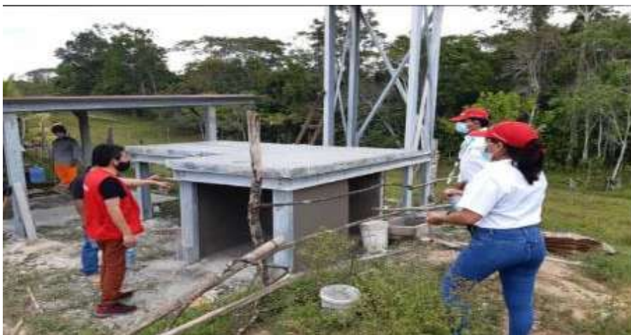
Figura 140 Placa colaborante, Modulo UBS y compostera terminada.
