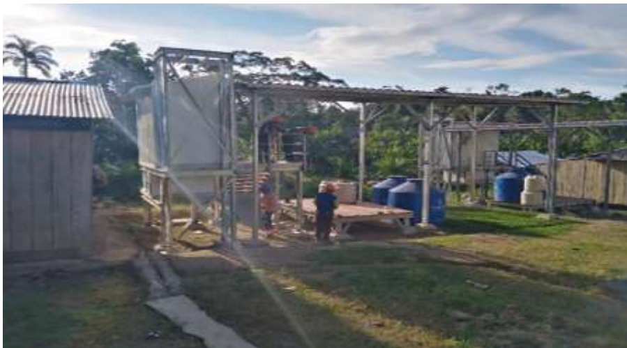
Figura 145 Colocación de modulo UBS en la localidad de 13 de febrero.
