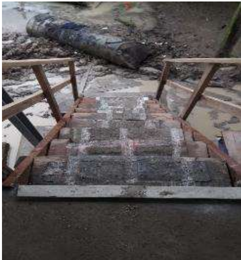
Figura 144 Instalación de acceso a desnivel de modulo UBS en la localidad de 13 de febrero
