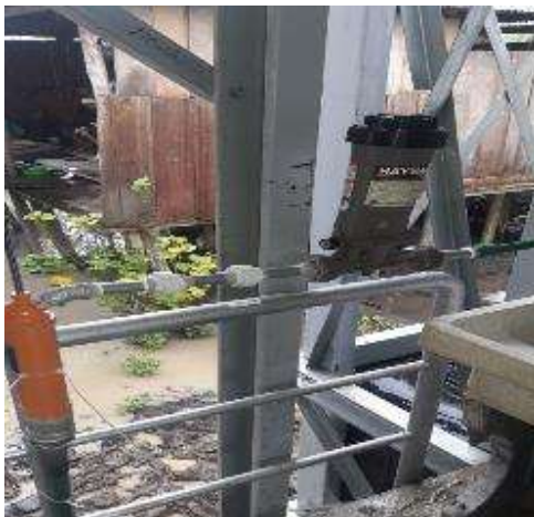
Figura 166 Instalación de clorador en línea y lavadero en modulo UBS en la localidad de 13 de febrero Fuente: Elaboración propia
