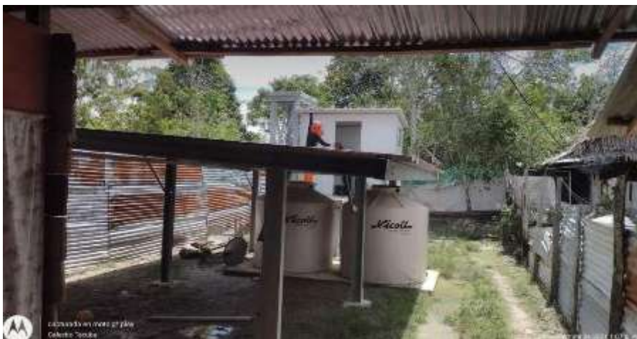
Figura 157 Vista de acabado de UBS con captación de agua pluvial en la localidad 13 de febrero Fuente: Elaboración propia
