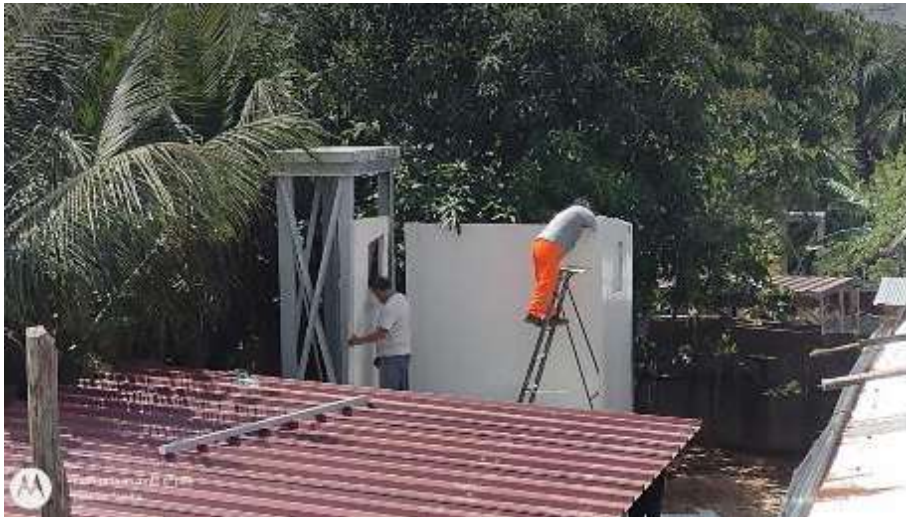
Figura 150 Instalación de Paneles de Aluzinc para cobertura de modulo UBS en la localidad 13 de febrero
