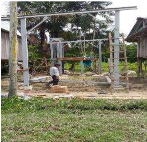
Figura 138. Montaje de verticales de Steel Framing de modulo UBS en la localidad de 13 de febrero Fuente: Elaboración propia
