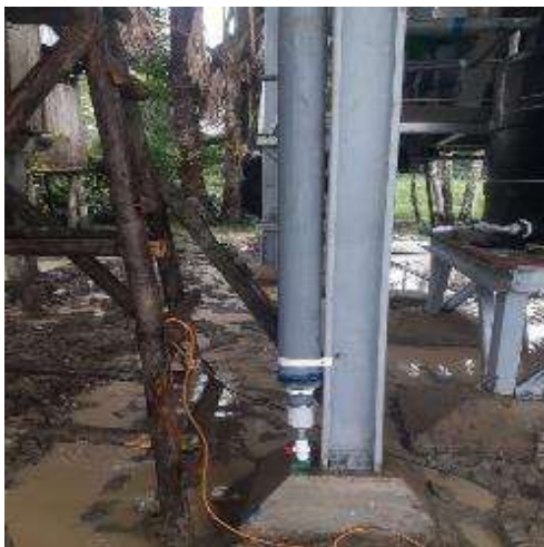
Figura 148 Instalación de tanqueta de agua para modulo UBS en la localidad de 13 de febrero
