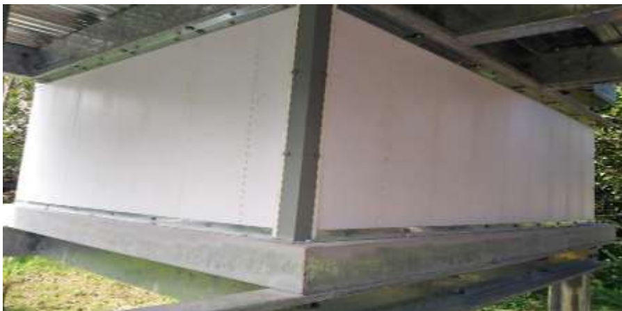
Figura 154 Vista de acabado de UBS en la localidad 13 de febrero
