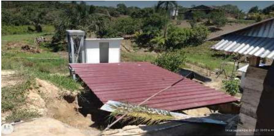
Figura 162 Vista de acabado de UBS en la localidad 13 de febrero Fuente: Elaboración propia
