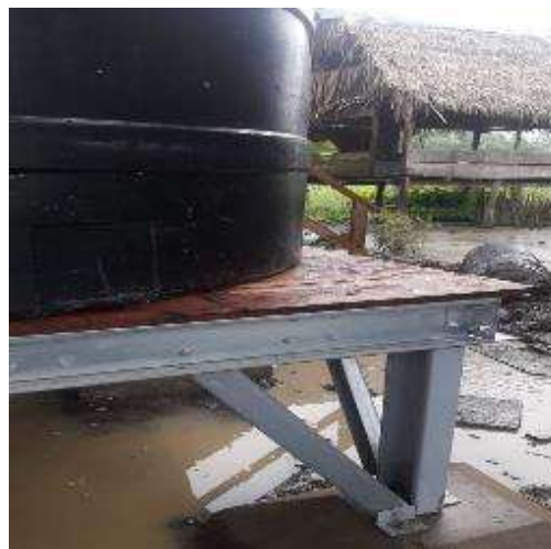
Figura 148 Instalación de tanqueta de agua para modulo UBS en la localidad de 13 de febrero
