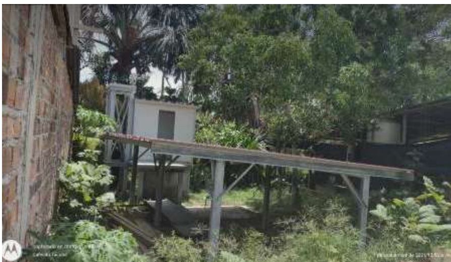
Figura 155 Vista de acabado de UBS con captación de aguas pluviales en la localidad 13 de febrero
