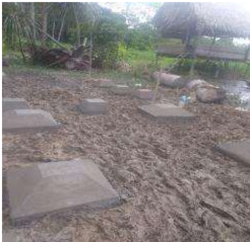
Figura 136. Colocación de concreto para las bases de modulo UBS en la localidad de 13 de febrero Fuente: Elaboración propia.
