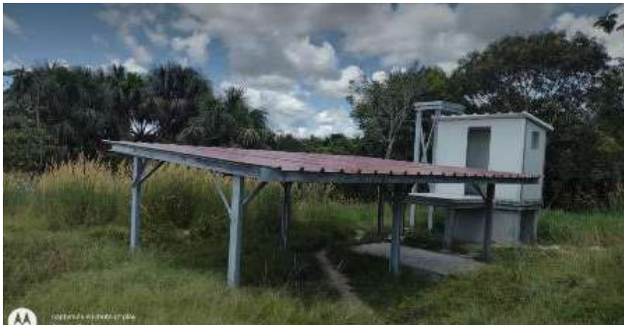
Figura 160 Vista de acabado de UBS en la localidad 13 de febrero Fuente: Elaboración propia
