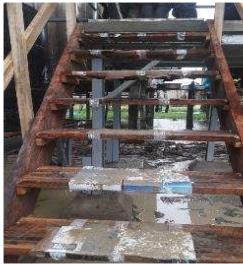
Figura 144 Instalación de acceso a desnivel de modulo UBS en la localidad de 13 de febrero
