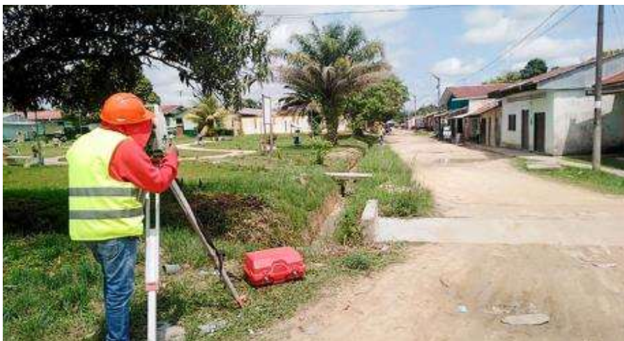
Figura 133. Trazo y replanteo de modulo UBS en la localidad de 13 de febrero Fuente: Elaboración propia
