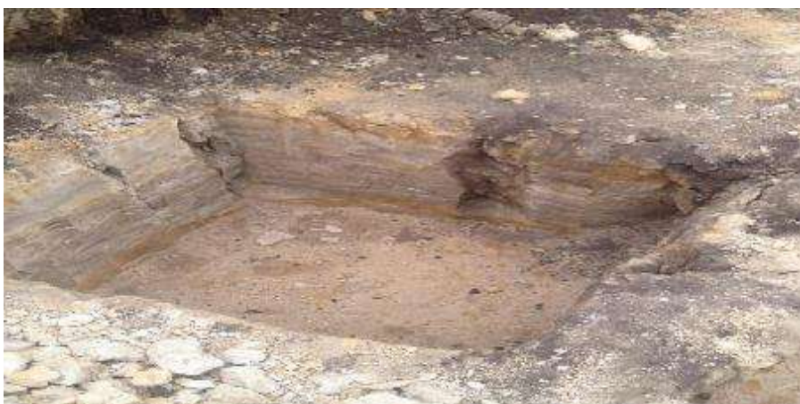
Figura 134. Excavación de zapatas para montaje de modulo UBS en la localidad de 13 de febrero Fuente: Elaboración propia
