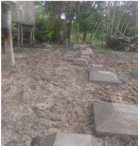
Figura 135. Colocación de concreto para las bases de modulo UBS en la localidad de 13 de febrero Fuente: Elaboración propia
