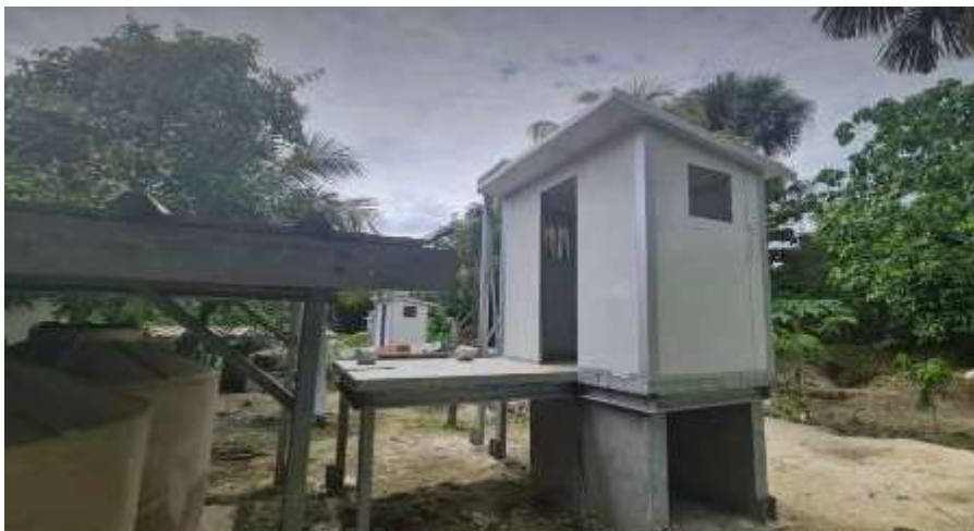
Figura 163 Vista de acabado y fosa compostera de UBS en la localidad 13 de febrero Fuente: Elaboración propia
