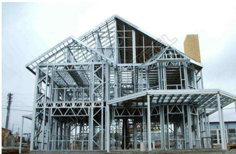
Figura 24 Edificación con Sistema Steel Framing
