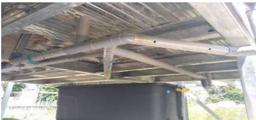
Figura 164 Instalación de tuberías sanitarias del módulo UBS en la localidad de 13 de febrero Fuente: Elaboración propia
