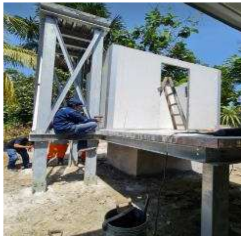
Figura 149 Colocación de Paneles de cobertura para modulo UBS en la localidad 13 de febrero
