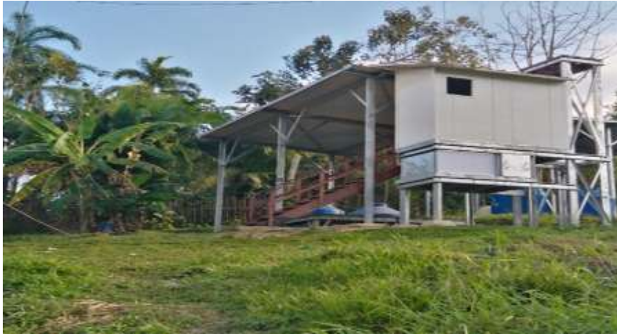
Figura 168 Vista de acabado de UBS en la localidad 13 de febrero
