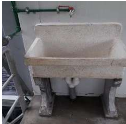
Figura 166 Instalación de clorador en línea y lavadero en modulo UBS en la localidad de 13 de febrero Fuente: Elaboración propia
