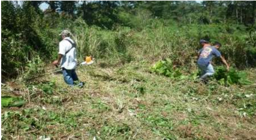
Figura 132. Limpieza manual de terreno para la construcción de modulo UBS en 13 de febrero Fuente: Elaboración propia
