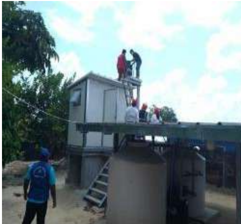
Figura 153 Instalación del tanque elevado (250 lts)
