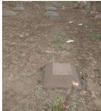
Figura 136. Colocación de concreto para las bases de modulo UBS en la localidad de 13 de febrero Fuente: Elaboración propia.
