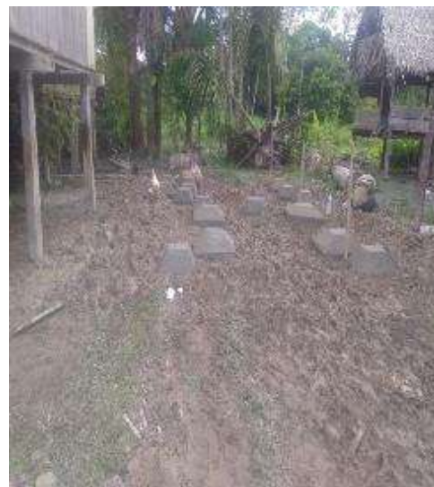
Figura 137. Colocación de concreto para las bases de modulo UBS en la localidad de 13 de febrero Fuente: Elaboración propia
