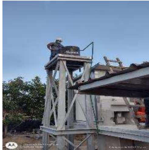
Figura 159 Vista de acabado de UBS con captación de agua pluvial en la localidad 13 de febrero Fuente: Elaboración propia
