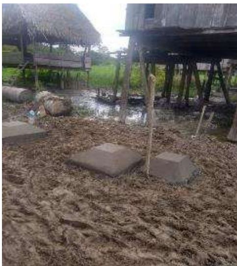
Figura 137. Colocación de concreto para las bases de modulo UBS en la localidad de 13 de febrero Fuente: Elaboración propia
