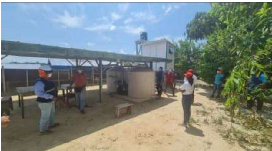
Figura 142 Almacenamiento del sistema de captación de aguas pluviales.
