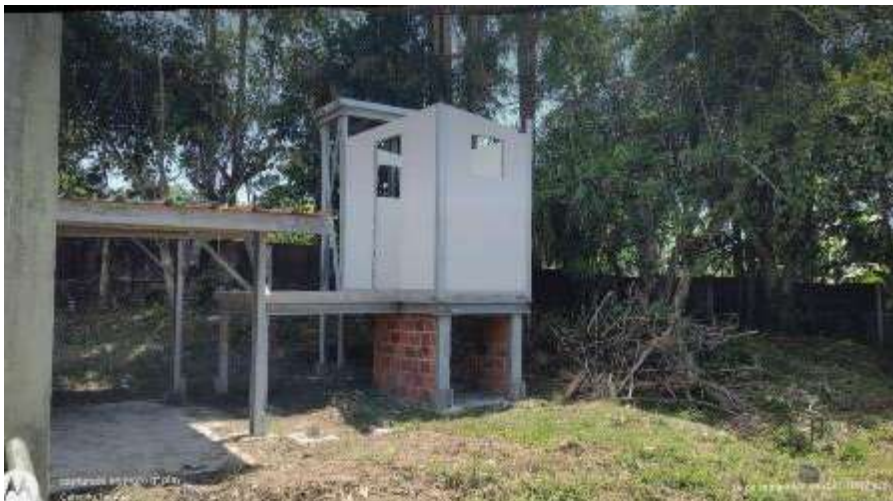
Figura 151 Colocación de modulo UBS en la localidad 13 de febrero
