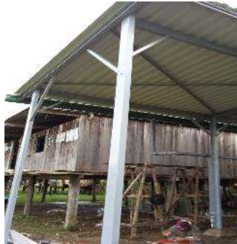
Figura 138. Montaje de verticales de Steel Framing de modulo UBS en la localidad de 13 de febrero Fuente: Elaboración propia
