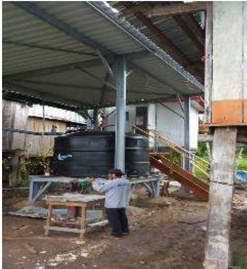
Figura 147 Instalación de Cisterna almacenamiento
