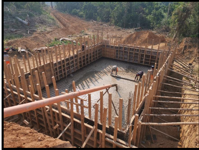
Ilustración 24 Vaciado losa y muro de lecho de secado
