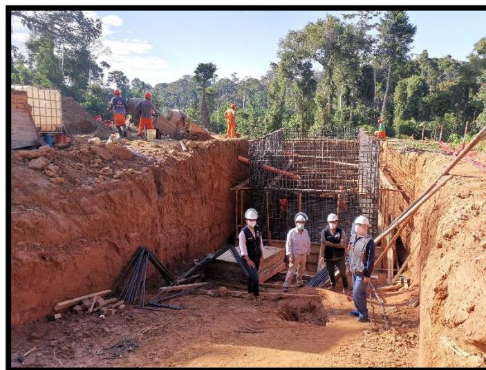
Ilustración 18 Armado de acero de los muros del tanque Imhoff
