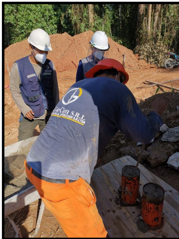
Ilustración 21 Control de calidad Tanque Imhoff
