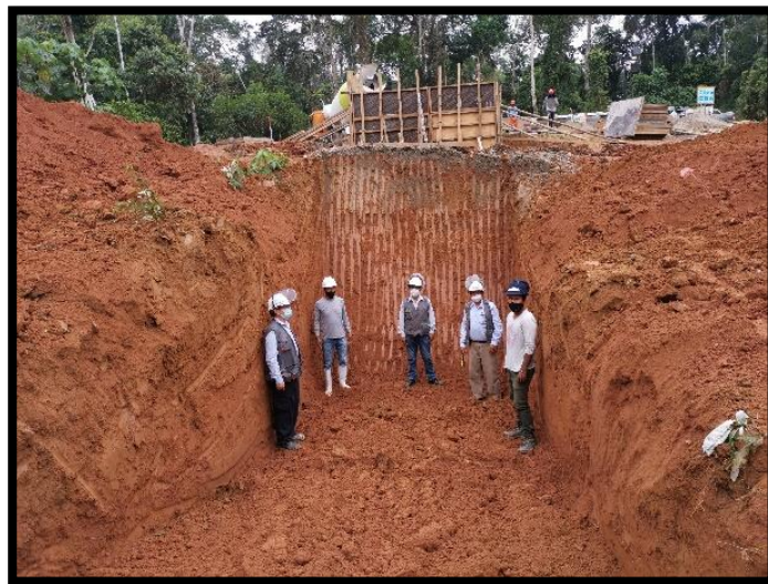
Ilustración 31 Movimiento de tierra sedimentador
