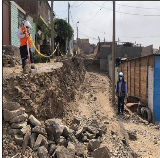
Figura 75 Zona conformada manualmente con material propio para muro de contención en el pasaje 16, supervisado por el ingeniero residente. Fuente elaboración propia
