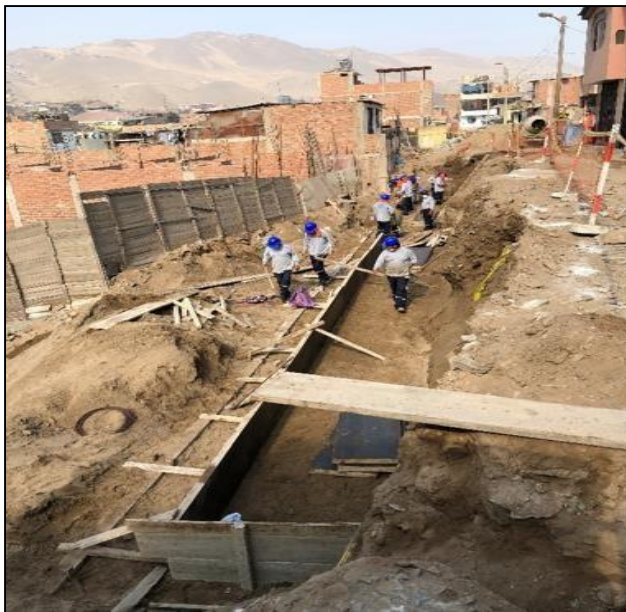
Figura 80 Arrostramiento de encofrado de cemento corrido para muro de contención en el pasaje 7 Fuente elaboración propia
