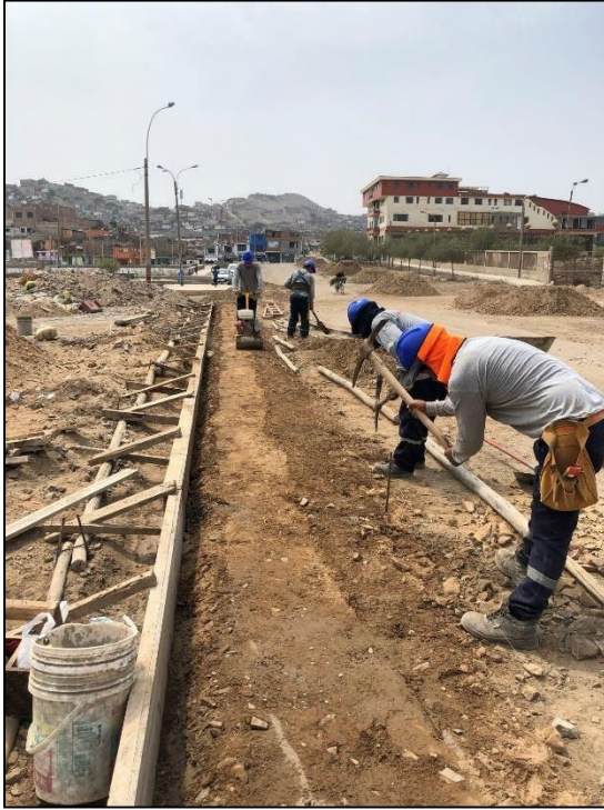
Figura 36 Compactación de material granular y encofrado de veredas en el Sector 5-Mz M10 Fuente elaboración propia
