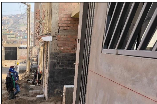
Figura 16 Excavación manual de veredas en el Sector 4-Mz I6 Fuente elaboración propia
