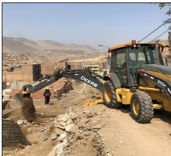
Figura 68 Corte de terreno normal con retroexcavadora para muro de contención en el pasaje B Fuente elaboración propia
