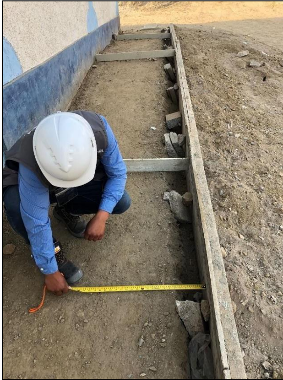
Figura 39 Verificación de los encofrados de veredas en el Sector 6-Mz M2 Fuente elaboración propia
