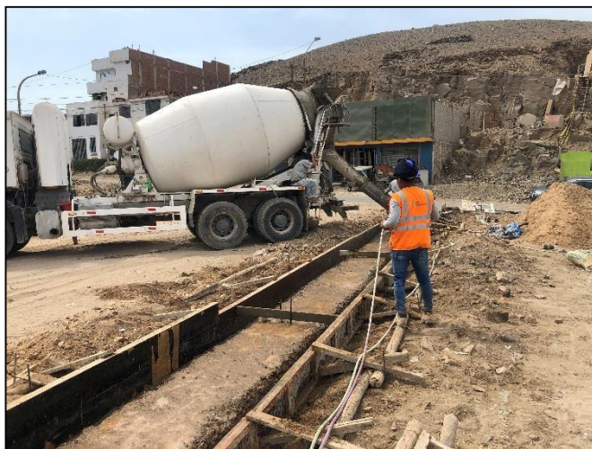
Figura 53 Humedecimiento de veredas antes del llenado de concreto en el Sector Fuente elaboración propia
