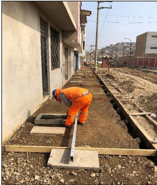
Figura 41 Verificación de los encofrados de veredas y nivelación de cajas de desagüe en el Sector 5-Mz I11 Fuente elaboración propia
