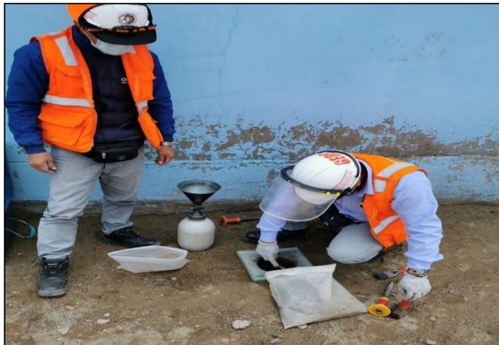
Figura 25 Ensayo de densidad de campo en la subrasante de vereda en el Sector 2-Mz H2 Fuente elaboración propia
