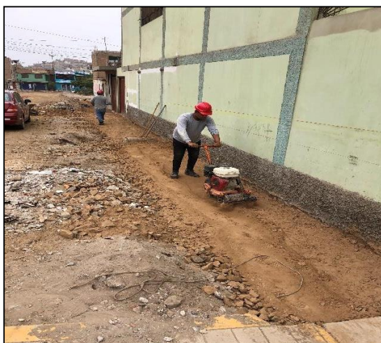
Figura 30 Compactación de material granular para la conformación de base granular de veredas en el Sector 3-Mz I1 Fuente elaboración propia
