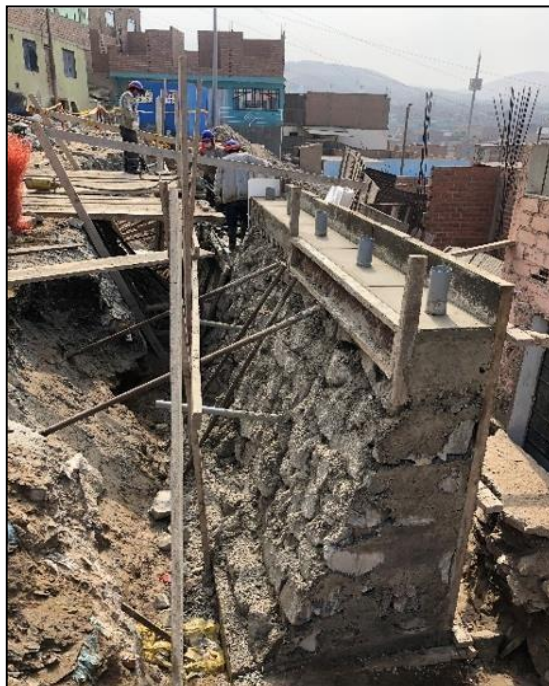
Figura 90 Asentado de piedra en pantalla de muro de contención y colocación de plancha de tecnopor como junta de dilatación en el Pasaje 6 Fuente elaboración propia
