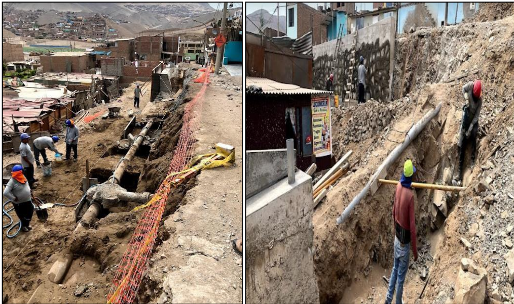
Figura 102 Replanteo de diseño de muro por el motivo que tubería de desagüe atravesaban la cimentación, debido a este motivo no se pudo utilizar maquinaria. Se optó por excavación manual, aumentando la mano de obra para esta actividad logrando culminar los muros en el pasaje B Fuente elaboración propia
