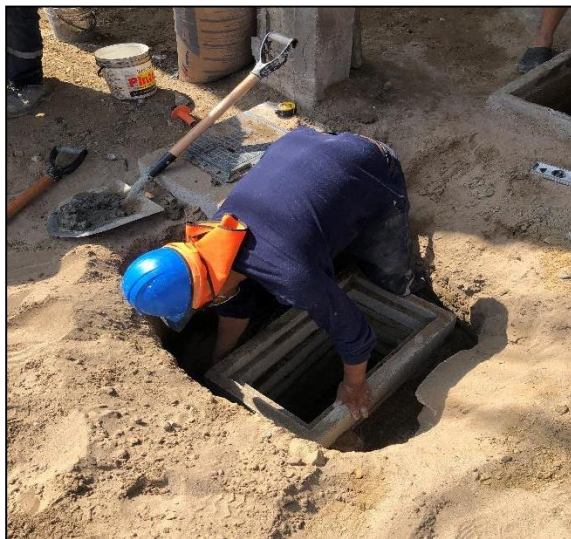
Figura 22 Cambio de pestañas y cajas de desagüe en el Sector 5-Mz I11 Fuente elaboración propia
