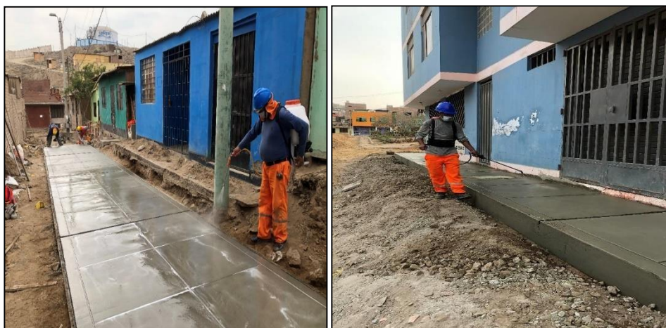
Figura 61 Curado químico de veredas con mochila fumigadora en el sector 4-Mz I7 y en el sector 2-Mz H2 Fuente elaboración propia
