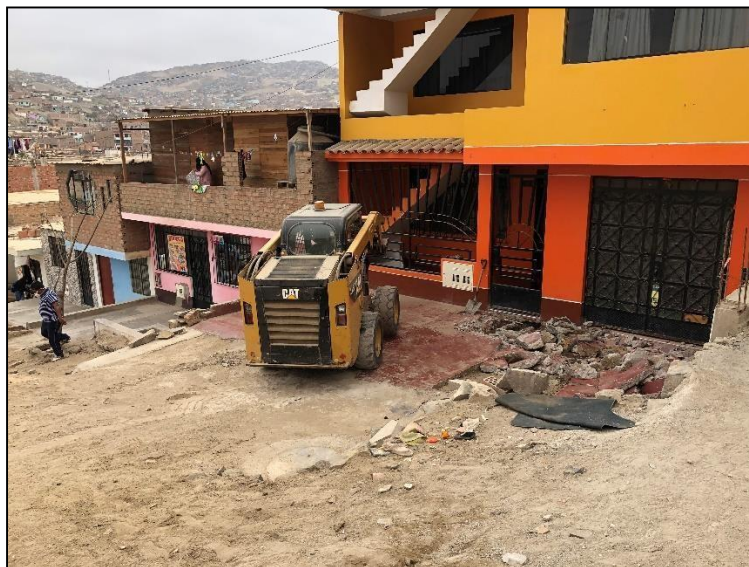
Figura 12 Demolición de Veredas y limpieza del área de trabajo en el Sector 2-Mz D2 Fuente elaboración propia
