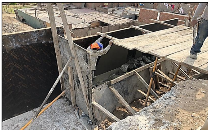
Figura 87 Asentado de piedra para muro de contención en el Pasaje 16 Fuente elaboración propia
