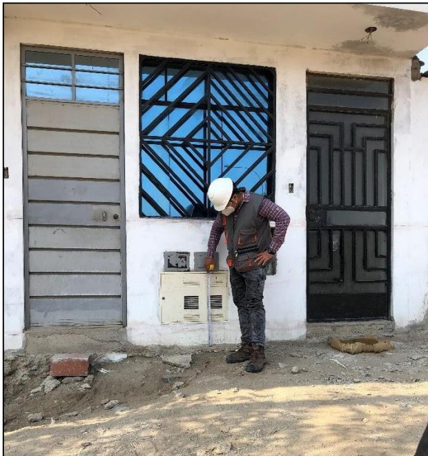
Figura 9 Verificación de Trazo de termino de vereda con Caja de Gas Cálida en el Sector 1-Mz G8 Fuente elaboración propia
