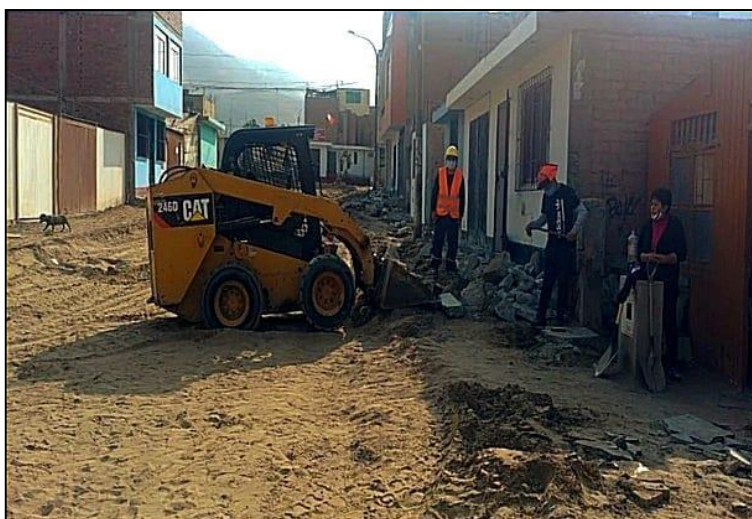
Figura 19 Eliminación de material excedente en el Sector 1-Mz G7 Fuente elaboración propia
