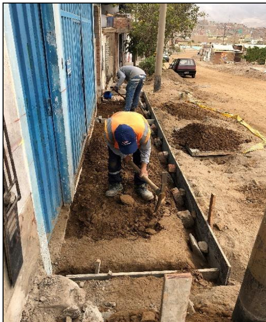
Figura 42 Corrección de base granular y encofrado de veredas en el Sector 5-Mz M3 Fuente elaboración propia
