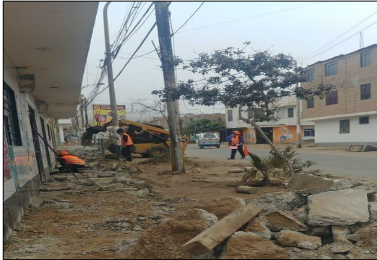
Figura 11 Demolición de Veredas en el Sector 1-Mz G2 Fuente elaboración propia
