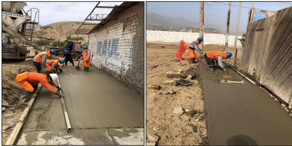
Figura 59 Frotachado de veredas con plancha metálica en el sector 5-MZ I11 y en el sector 4-MZ I9 Fuente elaboración propia
