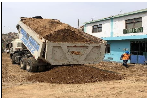
Figura 27 Llegada de material para la conformación de base granular de veredas en el Sector 1-Mz G1 Fuente elaboración propia
