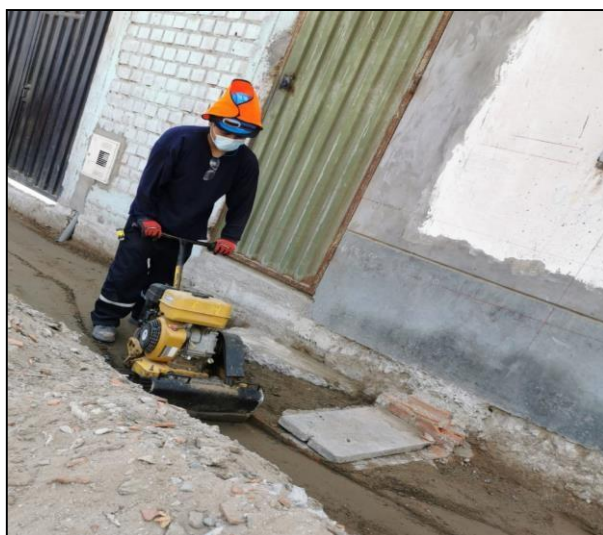
Figura 23 Conformación y compactación de subrasante de vereda en el Sector 4-Mz I10 Fuente elaboración propia
