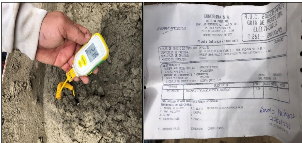
Figura 64 Prueba de temperatura del concreto y guía firmada por asistente de residente.
