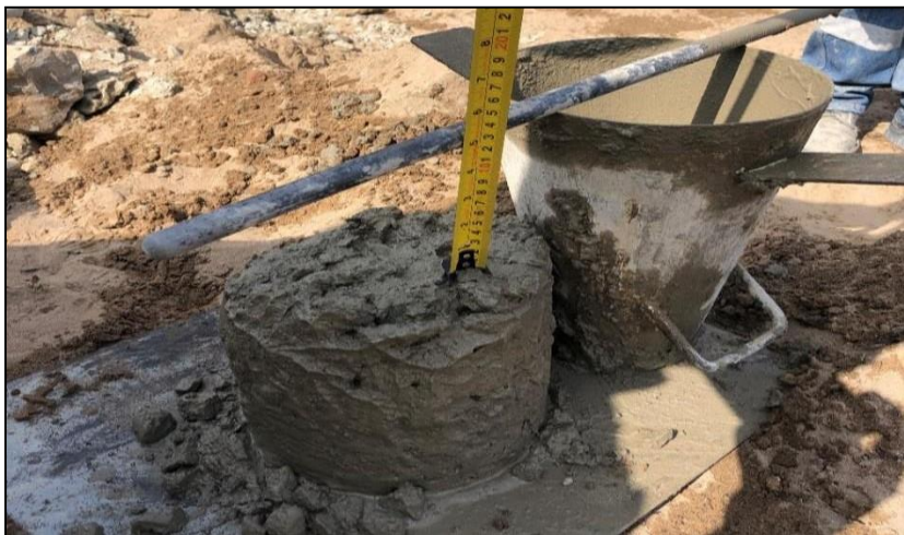
Figura 46 Medición con guincha del asentamiento de concreto que resulta ser de 5 pulgadas, para obra se pidió que el Slump sea de 4 a 6 pulgadas cumpliendo la concretera con lo solicitado. Fuente elaboración propia
