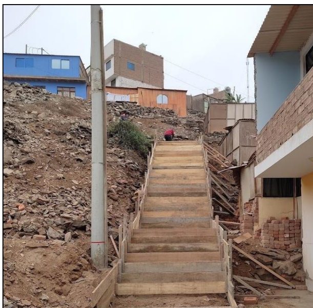
Figura 38 Encofrado de gradas y descanso en el Sector 3-Mz H3 Fuente elaboración propia
