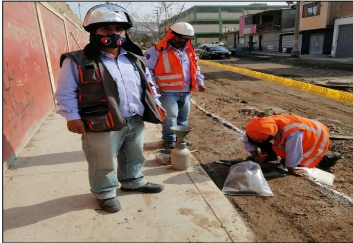
Figura 34 Ensayo de densidad de campo en la base granular de vereda en el Sector 4-I. E Cesar Vallejo con supervisión del Ingeniero Residente.
