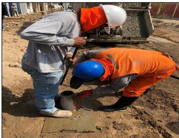
Figura 43 Realización de la prueba de asentamiento de concreto utilizando el cono de Abrams en el Sector 4-Mz I10
