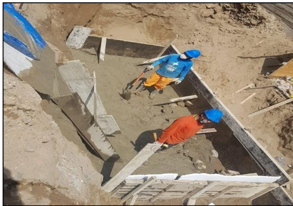
Figura 81 Llenado de cimiento corrido de muro de contención en el Pasaje 7 Fuente elaboración propia
