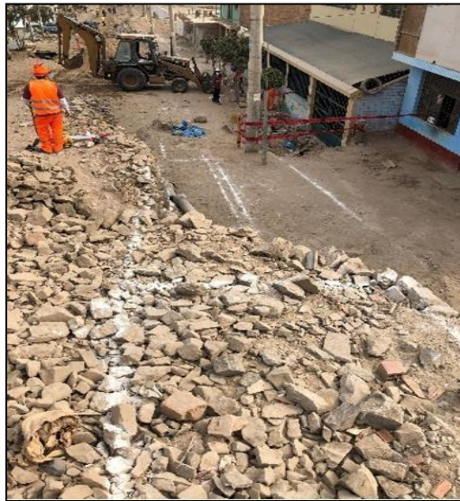
Figura 66 Trazo y replanteo de muro de contención en la Calle D Fuente elaboración propia
