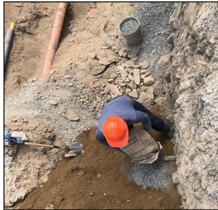
Figura 95 Colocación de gravilla en tubería de drenaje en el pasaje 7. Fuente elaboración propia
