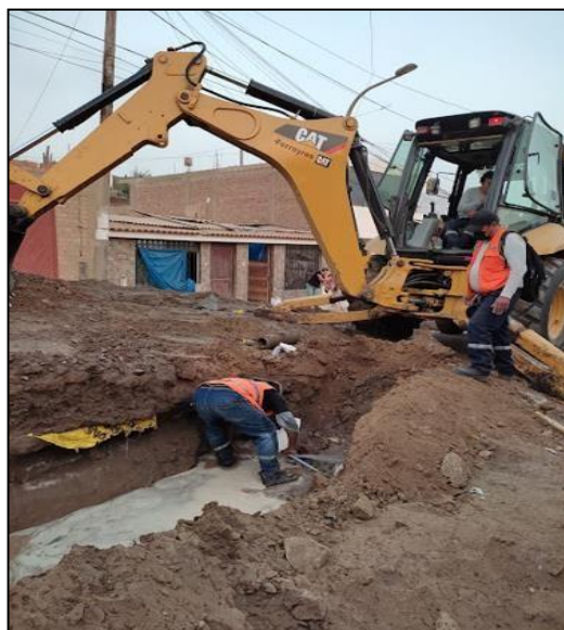
Figura 72 Corte de terreno normal con retroexcavadora para muro de contención en la calle 35, donde se encontró y rompió la tubería domiciliaria de agua, también se encontró tubería de gas. Fuente elaboración propia
