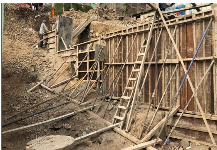
Figura 85 Encofrado de pantalla de muro de contención en la calle D, donde se evidencia el perfil longitudinal del muro y la diferencia de niveles. Fuente elaboración propia
