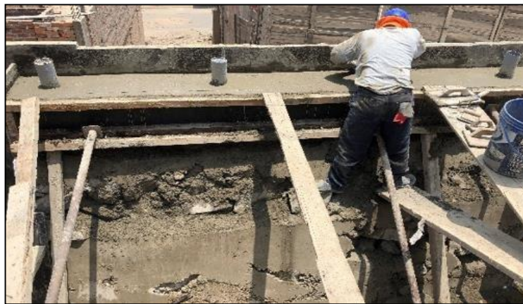
Figura 91 Acabado final de la corona del muro de contención y colocación de tubería para las barandas de madera en la calle 35 Fuente elaboración propia
