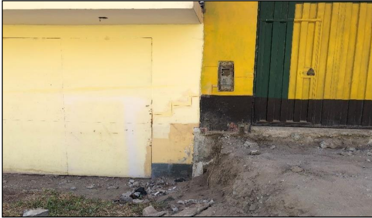
Figura 7 Trazo en vivienda para tener la distancia de la vereda terminada y desnivel que amerita gradas, en el sector 3-Mz H5 Fuente Elaboración propia
