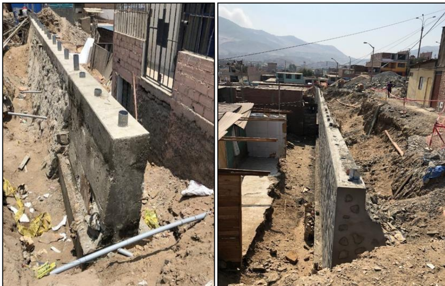
Figura 92 Acabado final del muro de contención en el Pasaje 6 y Pasaje 7, respetando los lineamientos del plano con tubería de drenaje, tubería para instalación de barandas y juntas de dilatación. Fuente elaboración propia
