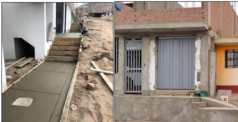
Figura 100 Replanteo de vereda, con implementación de gradas para no obstruir la transitabilidad vial mejorando la conexión entre viviendas. Fuente elaboración propia
