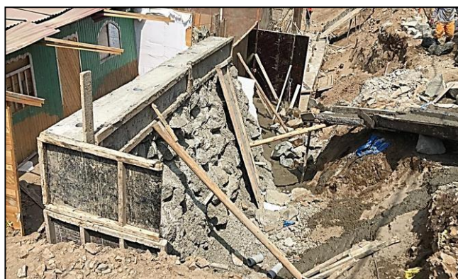
Figura 88 Asentado de piedra con drenaje con tubería de 2” en el Pasaje B Fuente elaboración propia
