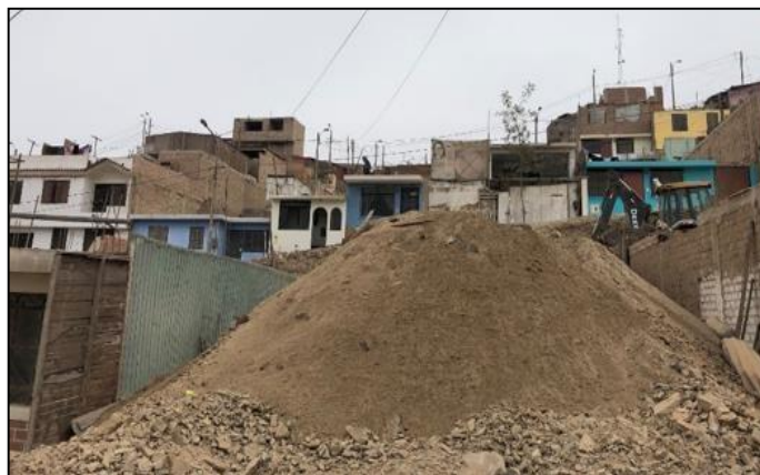
Figura 76 Zona de acoplo de material excedente para su próxima eliminación con maquinaria. Fuente elaboración propia
