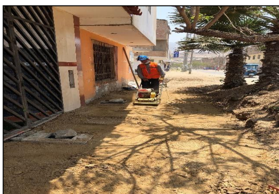
Figura 31 Compactación de material granular para la conformación de base granular de veredas en el Sector 2-Mz H7 Fuente elaboración propia
