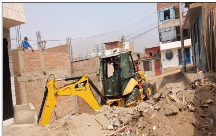
Figura 71 Corte de terreno normal con retroexcavadora para muro de contención en el pasaje 6 Fuente elaboración propia
