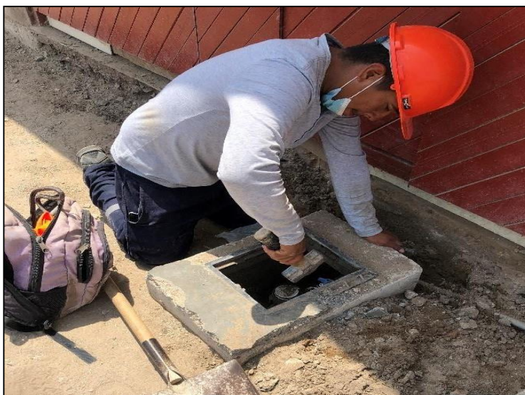
Figura 14 Reparación de conexiones domiciliarias de agua en el Sector 5-Mz I11 Fuente elaboración propia
