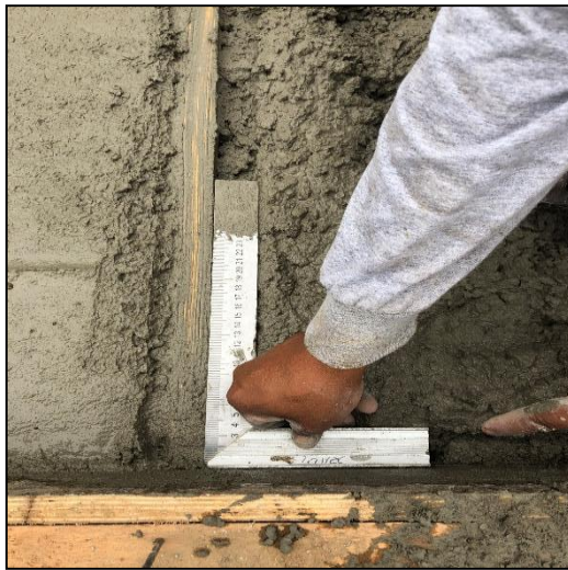
Figura 55 Verificación con escuadra de la junta de vereda en el sector 6-Mz M9 Fuente elaboración propia
