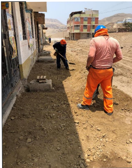
Figura 29 Tendido de material granular para la conformación de base granular de veredas en el Sector 4-Mz I9 Fuente elaboración propia
