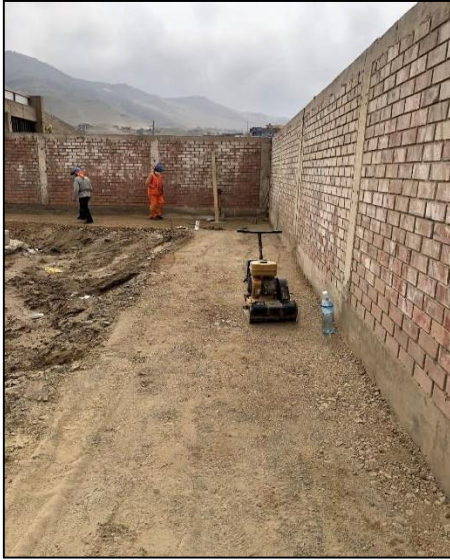
Figura 32 Compactación de material granular para la conformación de base granular de veredas en el Sector 4- Estadio Municipal Fuente elaboración propia
