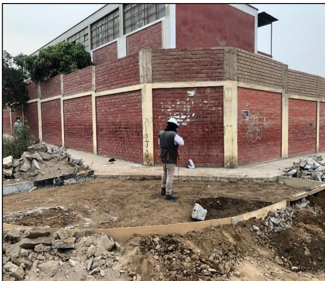
Figura 37 Compactación de material granular y encofrado de martillo de vereda en el Sector 4-I. E Cesar Vallejo Fuente elaboración propia
