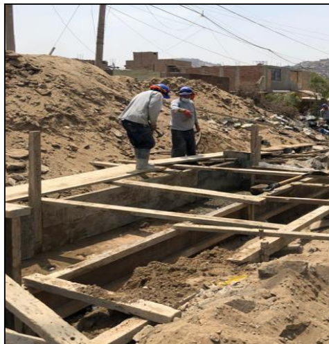
Figura 78 Encofrado de cimiento corrido de muro de contención en la Calle D
