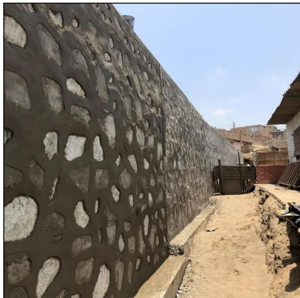
Figura 93 Emboquillado del muro de contención en el Pasaje 7 Fuente elaboración propia
