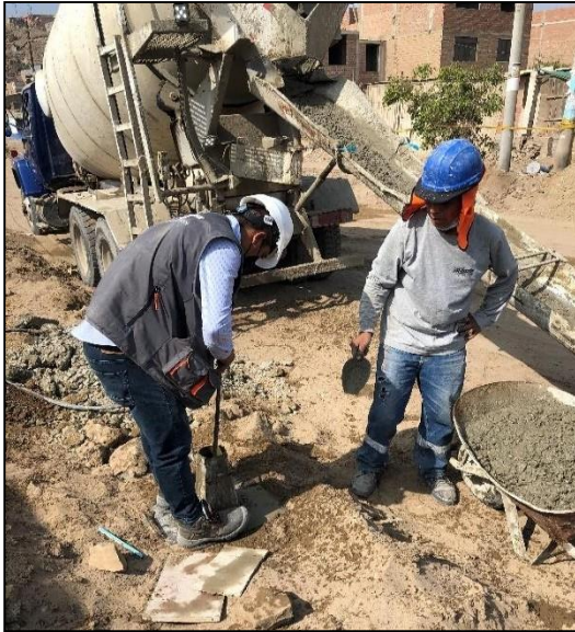
Figura 45 Realización de la prueba de asentamiento de concreto utilizando el cono de Abrams por parte de la supervisión en el Sector 6-Mz Ñ7 Fuente elaboración propia
