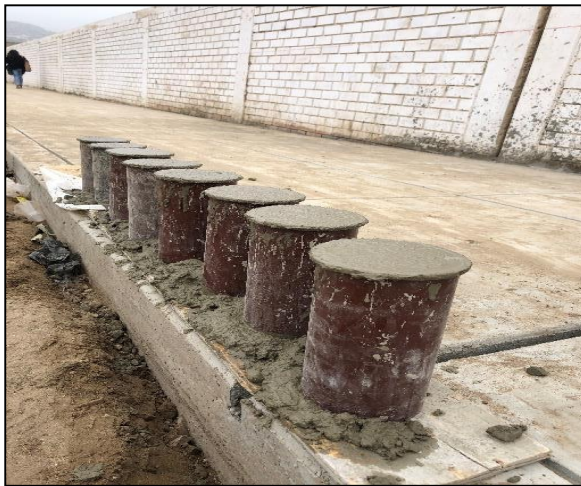
Figura 51 Muestras de probetas de concreto sacadas en obra para sus futuras pruebas de resistencia de compresión en el laboratorio.
