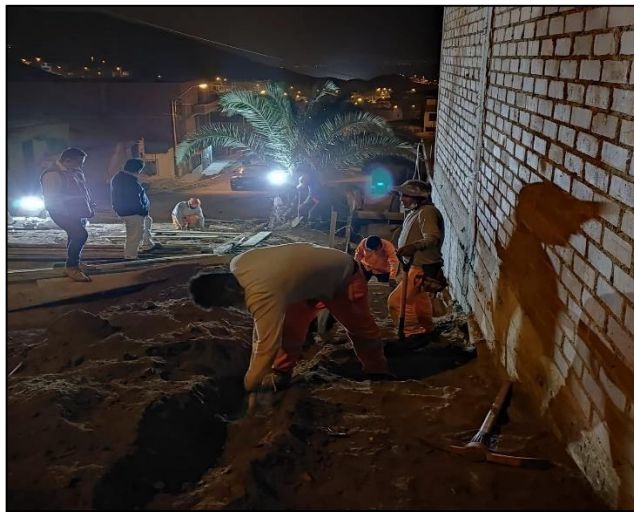
Figura 15 Excavación Manual de veredas en el Sector 6-Mz O2 Fuente elaboración propia
