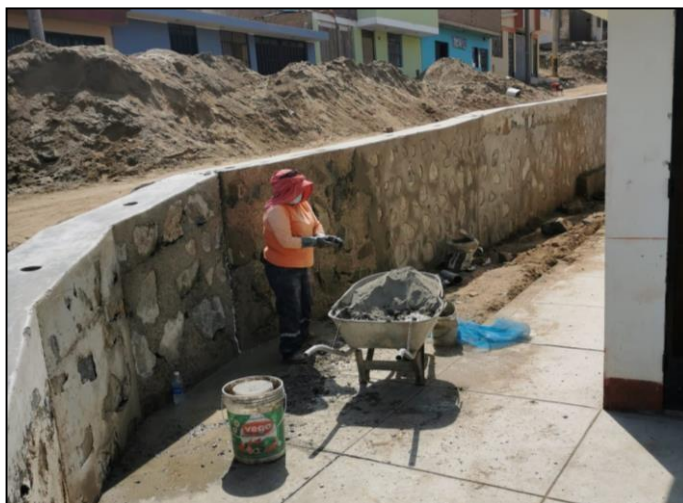
Figura 94 Emboquillado del muro de contención en la Calle 35 Fuente elaboración propia
