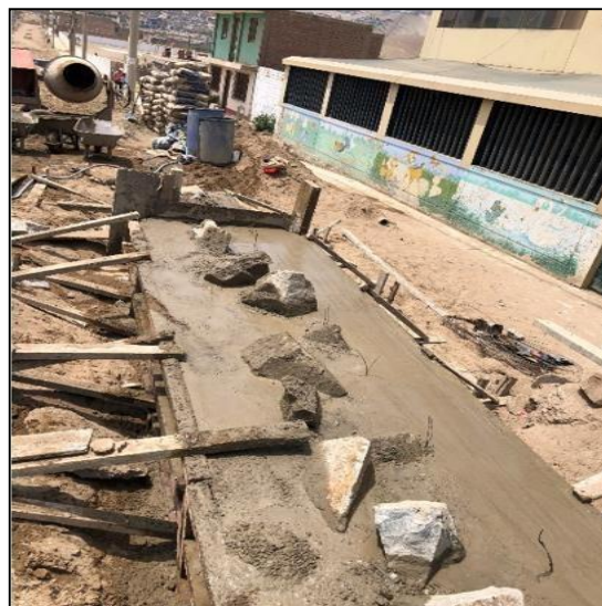
Figura 82 Llenado de cimiento corrido de muro de contención en la Calle D Fuente elaboración propia
