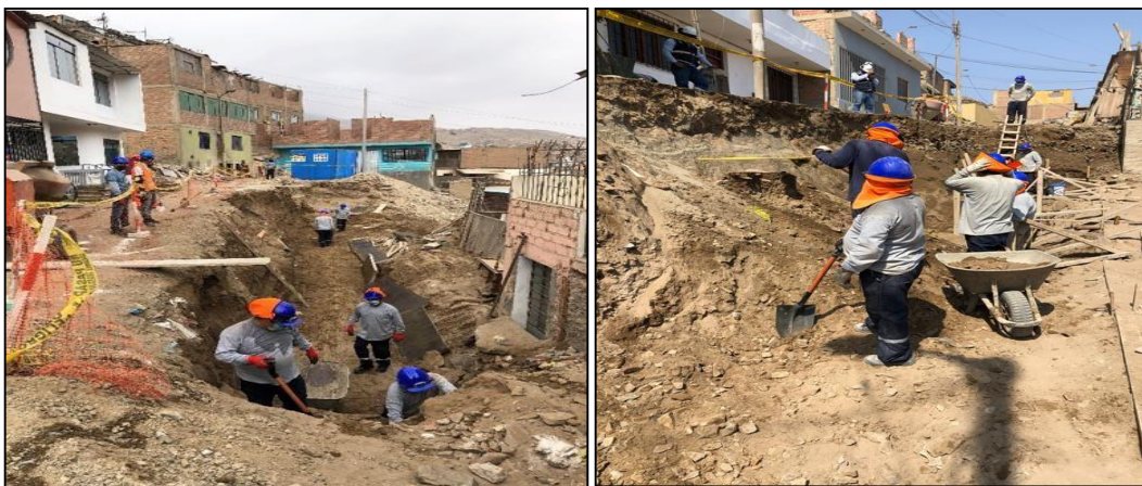
Figura 74 Conformación de terreno con material propio para muro de contención en el pasaje 6 y el pasaje 16 Fuente elaboración propia
