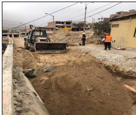
Figura 96 Relleno con material propio en el muro de contención en el Pasaje 7 Fuente elaboración propia
