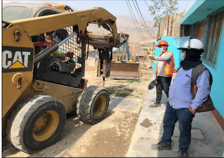
Figura 13 Demolición de Veredas, supervisada por el Residente de obra en el Sector 3-Mz I3 Fuente elaboración propia
