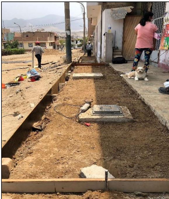
Figura 40 Verificación de los encofrados de veredas en el Sector 1-Mz G7 Fuente elaboración propia
