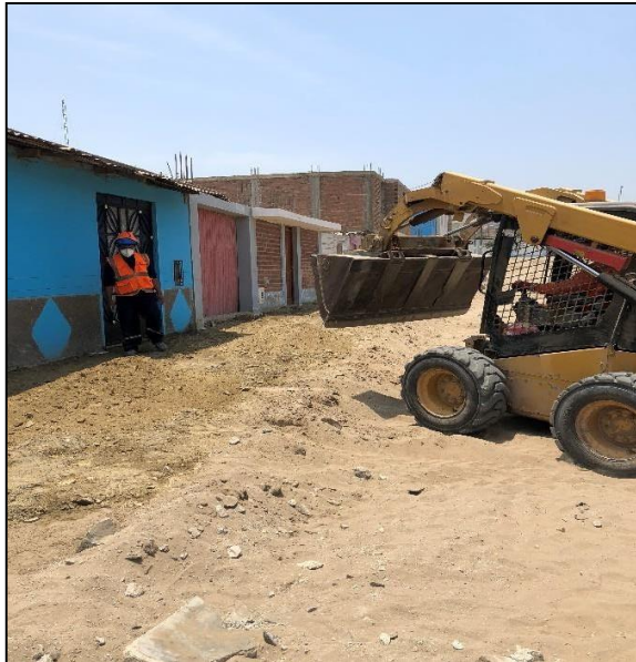
Figura 28 Tendido de material granular con la ayuda del mini cargador para la conformación de base granular de veredas en el Sector 5-Mz II I Fuente elaboración propia
