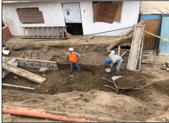
Figura 79 Encofrado de cemento corrido para muro de contención en el pasaje 7, se realizó con cuidado debido a que cerca de la cimentación pasaba una tubería de Sedapal. Fuente elaboración propia
