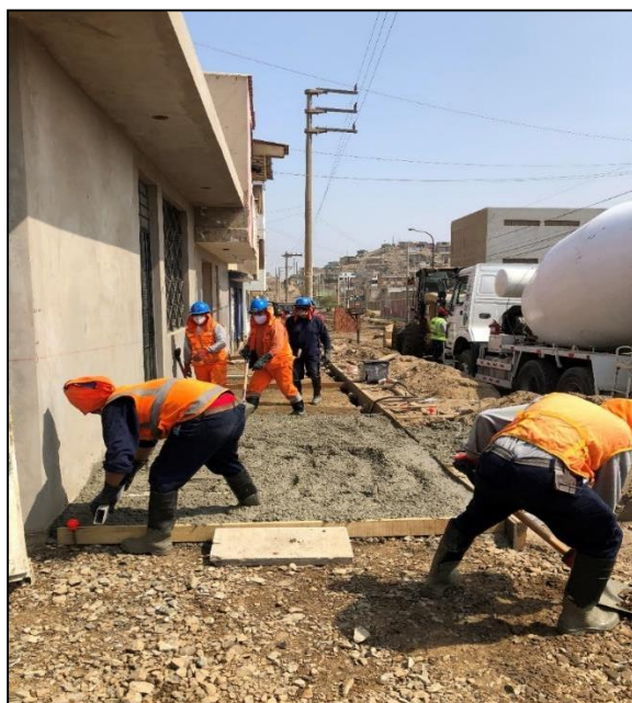
Figura 54 Llenado de veredas de concreto en el sector 4-Mz I11 Fuente elaboración propia
