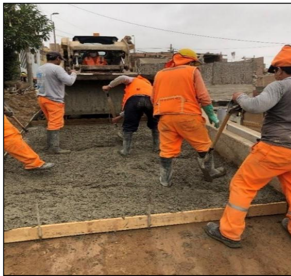
Figura 57 Llenado de veredas de concreto con ayuda de maquinaria en el sector 3-Mz I8 Fuente elaboración propia
