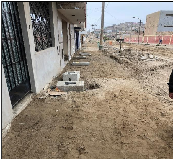
Figura 21 Conformación de subrasante de vereda en el Sector 5-Mz I11 Fuente elaboración propia
