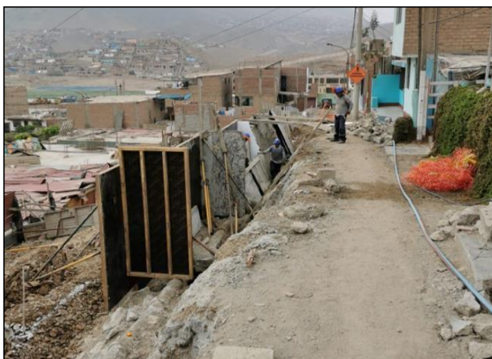
Figura 86 Encofrado de pantalla de muro de contención en el Pasaje B, para posterior asentado de muro Fuente elaboración propia
