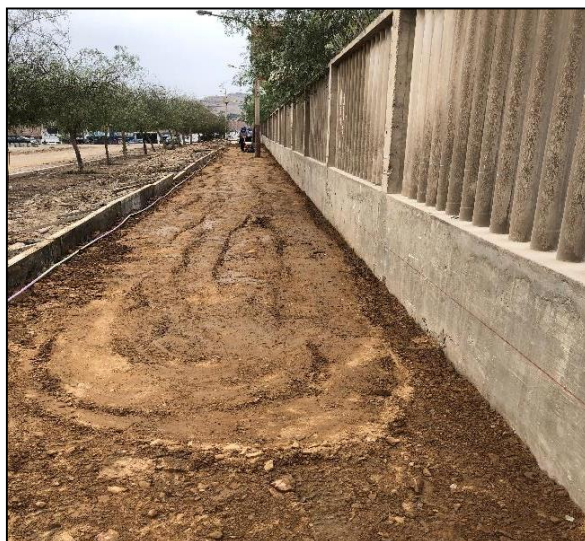
Figura 35 Compactación de material granular y encofrado de veredas en el Sector 6-Mz 9
