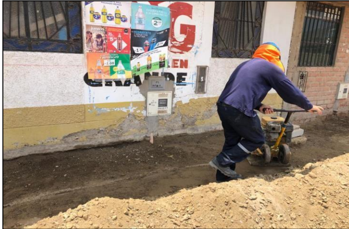
Figura 24 Conformación y compactación de subrasante de vereda en el Sector 3-Mz I2 Fuente elaboración propia
