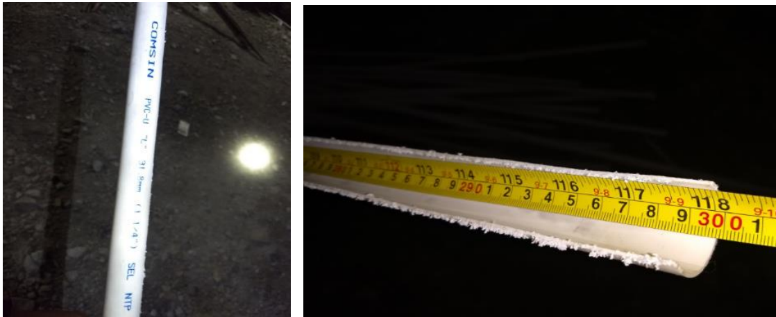
SE EMPLEA TUBOS DE PVC DE 1 1/4" Ø Y SE CORTAN A LA MITAD DE FORMA
