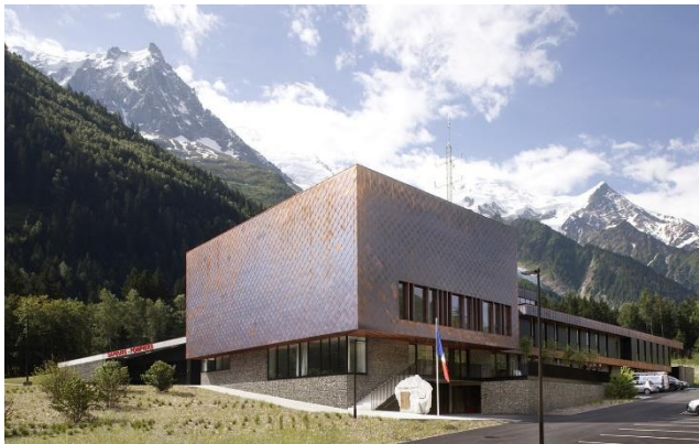
Figura 1 Estación de bomberos en Valle Chamonix – Mont Blanc. Jerome Ricolleau (2016).
