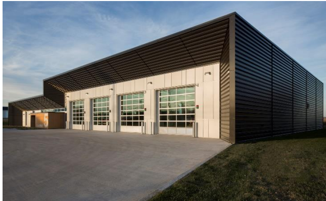
Figura 2 Estación de bomberos #5 de Ville de Québec. Stéphane Groleau (2016)
