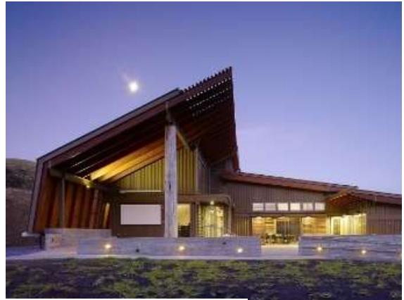
Figura n.º 11 Edificio de Ciencias
