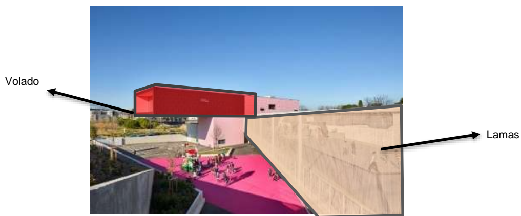
Figura n.º 26 Protección solar – Escuela
