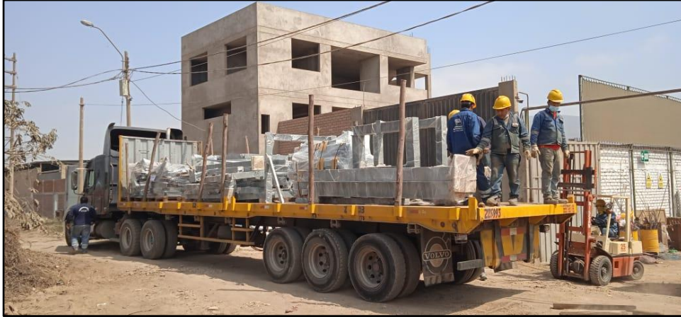
Anexo 5: Despacho de Estructuras de Metálicas
