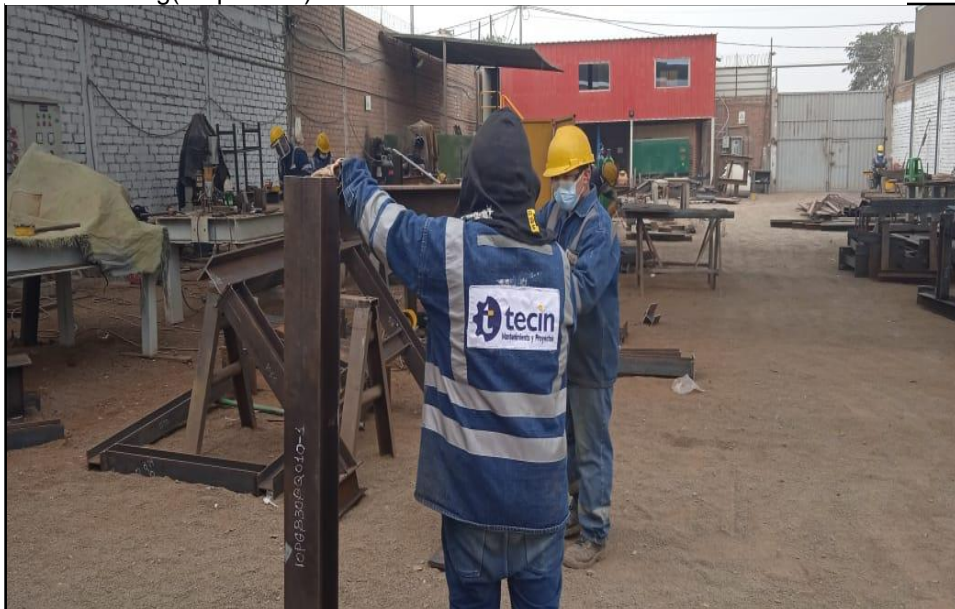
Anexo 4: Tag(etiquetado) de Estructuras Metálicas
