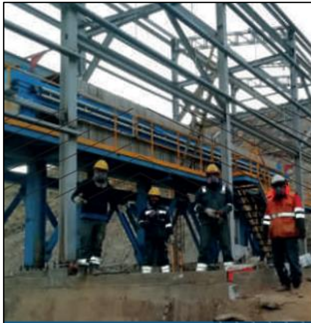
Figura 2: Montaje de Nave Estructural de Zona de Chancado
