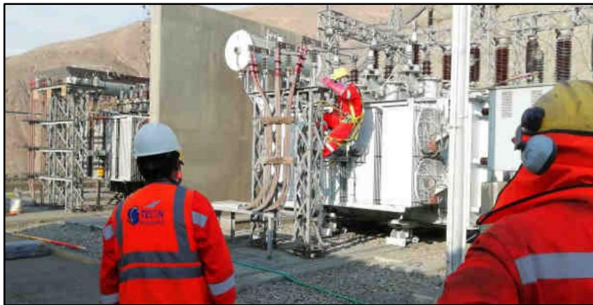
Figura 5: Montaje e instalación de cables M.T. en canaletas
