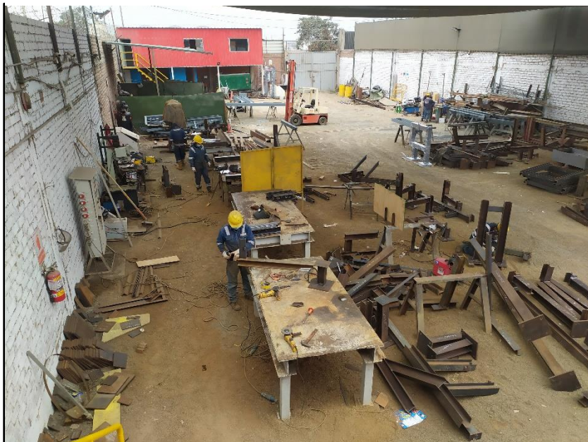
Anexo 2 : Zona de Habilitado de Estructuras
