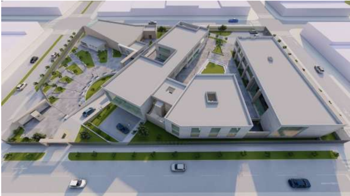
Figura 39: Vista exterior n° 01
