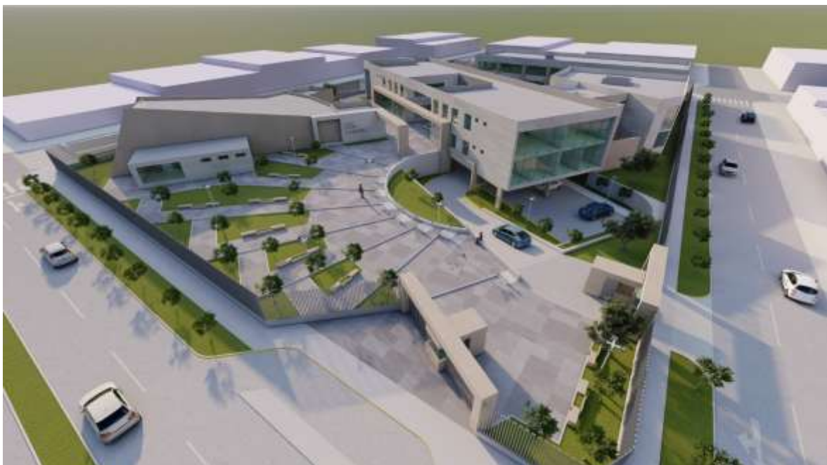
Figura 40: Vista exterior n° 02
