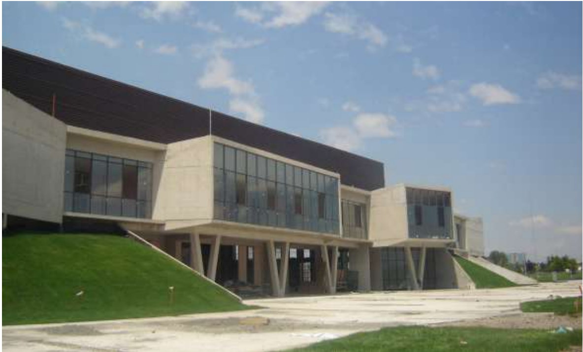
Figura 3: Fachada lateral izquierda del centro de eventos “Puente verde”
