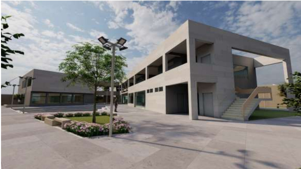
Figura 43: Vista exterior n° 05
