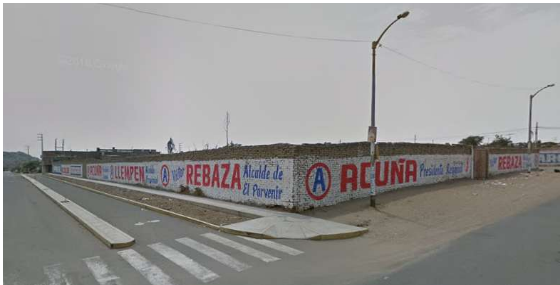
Figura 19: Frente norte con la avenida Vergara
