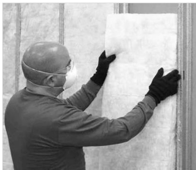
Figura 27. Reparación de aislamiento de hornos
