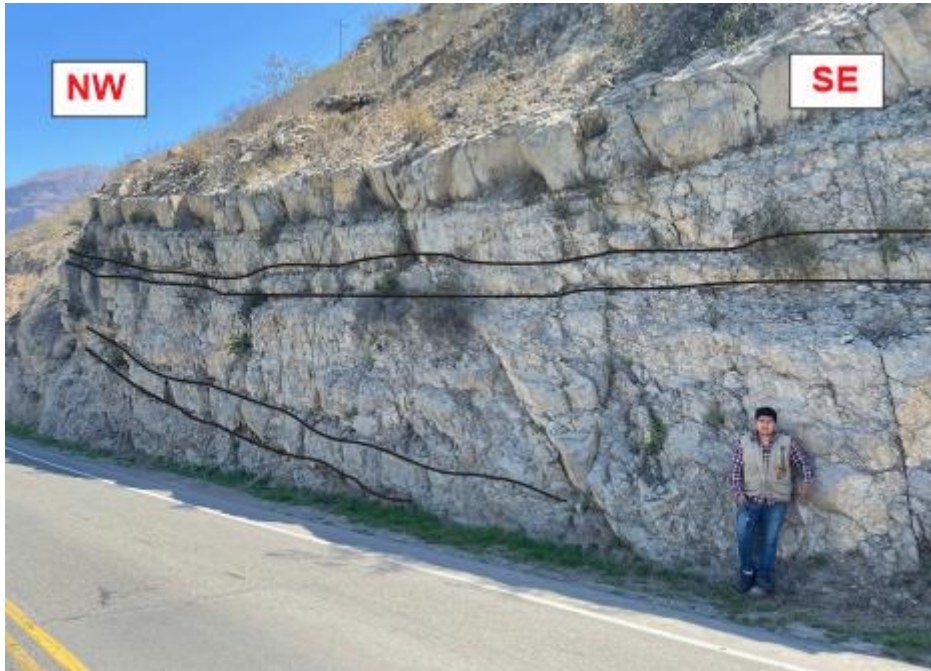
Figura 19 Secuencia de sedimentación de intercalación de calizas potentes y lutitas de menor espesor, con reconocimiento de familia de diaclasas
