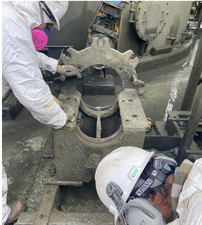
Figura n° 13 Cambio de portarodamiento y partes húmedas; Fuente: Elaboración propia
