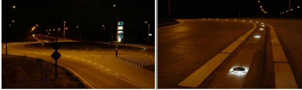
Figura 14. Ejemplo de iluminación LED para mejorar la visibilidad de los divisores de carril Fuente: Ministry of Transport, Public Works and Water management Partners for Roads. (2009). Roundabouts - Application and Design.
