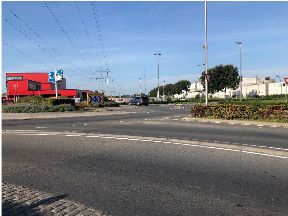
Figura 12. Divisor de carril elevado en una rotonda turbo en Países Bajos Fuente: Federal Highway Administration. (2019). Turbo Roundabouts: Informational Primer.
