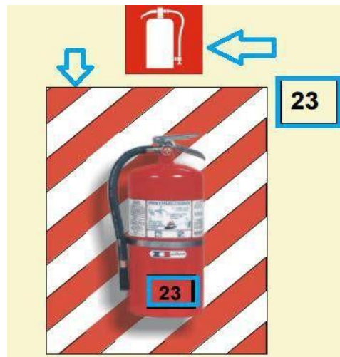
Figura 50: Enumeración respectiva de extintor.
