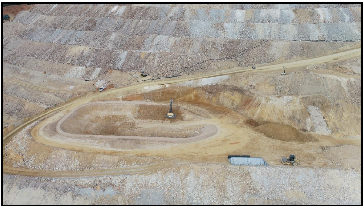
Figura X: Corte para conformación de poza.
