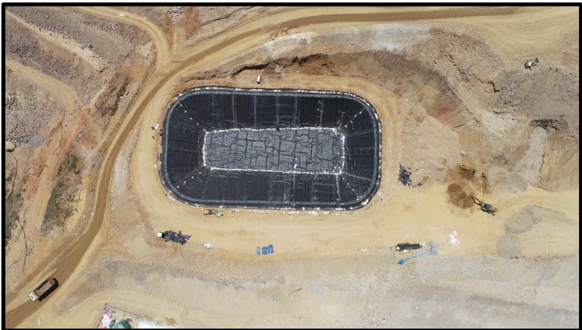
Figura XII: Poza del sistema de neutralización terminada
