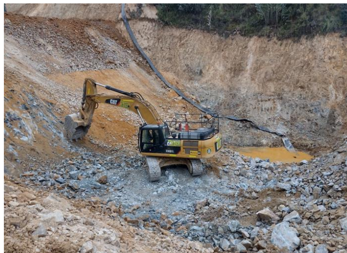
Figura II: Excavadora 336DL propiedad de la contratista ECOSM SHIRACMACA en la mina el SUMMA GOLD CORPERATION – cucharón: 2.6m 3
