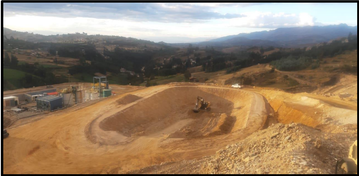
Figura XI: Excavación en poza de neutralización
