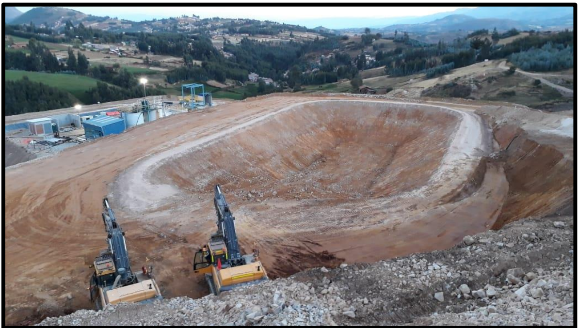
Figura VIII: Corte con excavadora 380DL para la conformación de la poza
