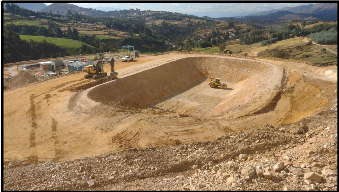
Figura IX: Compactación para la conformación de la poza
