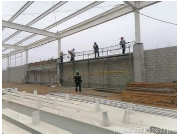
Figura 8 Caminatas Gemba para Vaciado Vigas
