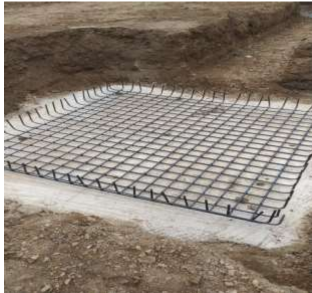
Figura 2 Caminatas Gemba para Vaciado de Zapata.
