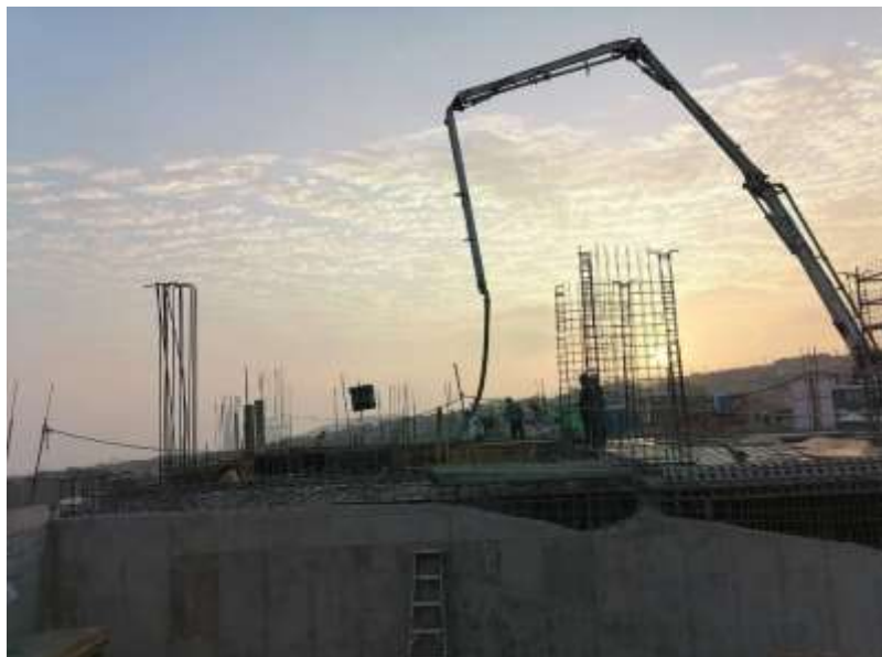
Figura 7 Caminatas Gemba, para Vaciado de Muros.
