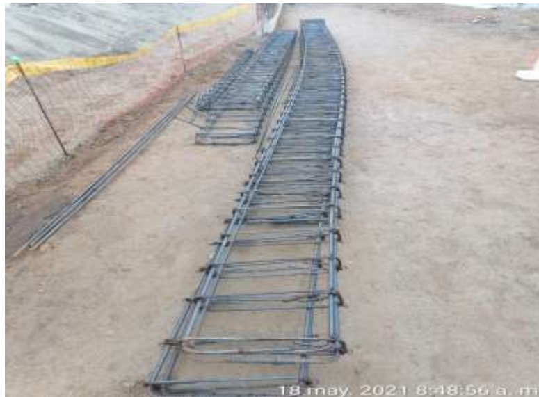
Figura 9 Caminatas Gemba para Vaciado Vigas.
