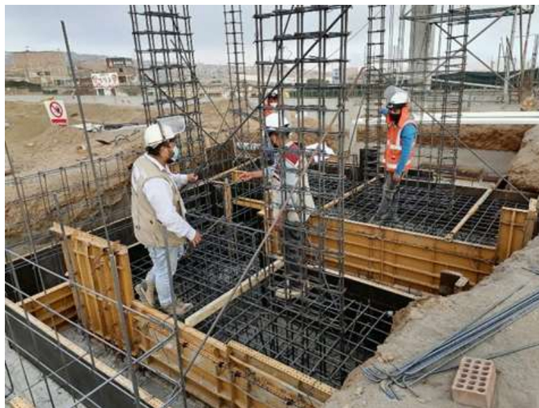
Figura 27 Caminatas Gemba Post Mejoras Vaciado de Zapata.
