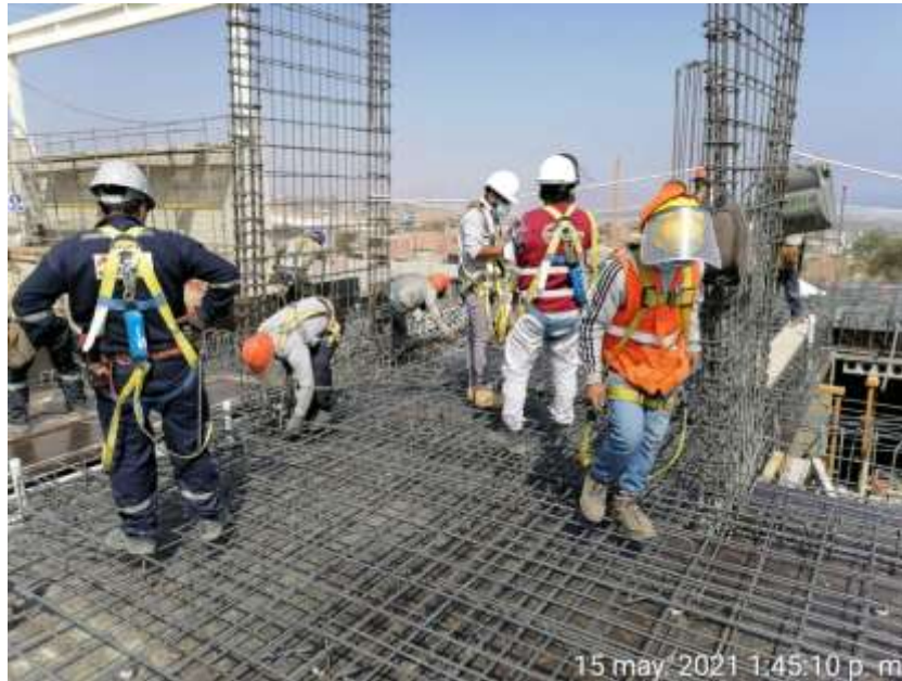
Figura 10 Caminata Gemba para Vaciado de Losa.
