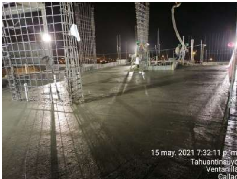
Figura 11 Caminata Gemba para Vaciado de Losa
