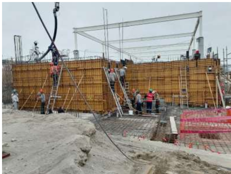
Figura 5 Caminata Gemba para Vaciado de Muros.
