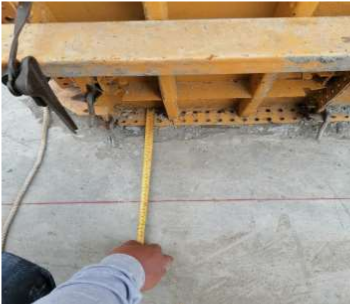
Figura 20 Caminatas Gemba Vaciado de Columna.
