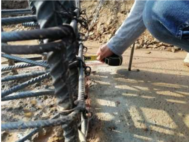
Figura 4 Columna Desfasada
