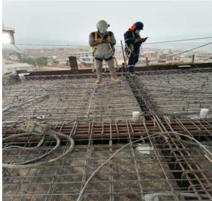
Figura 24 Caminatas Gemba Post Mejoras Vaciado de Losa.
