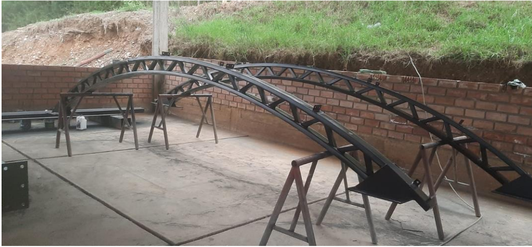
Figura 12. Estructuras Metálicas de techo
