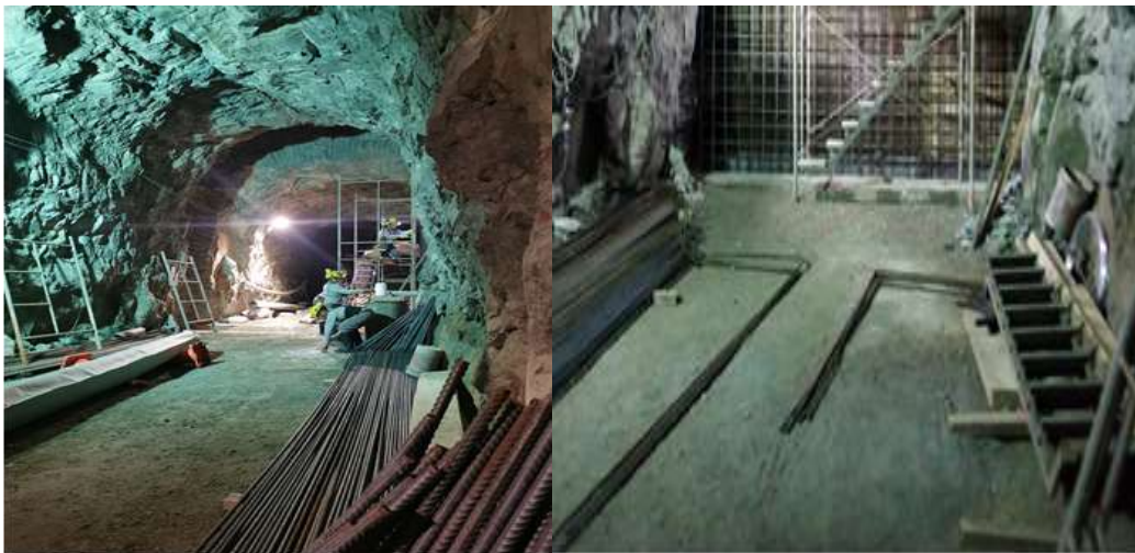
Figura 9: Habilitado y enmallado de acero de refuerzo
