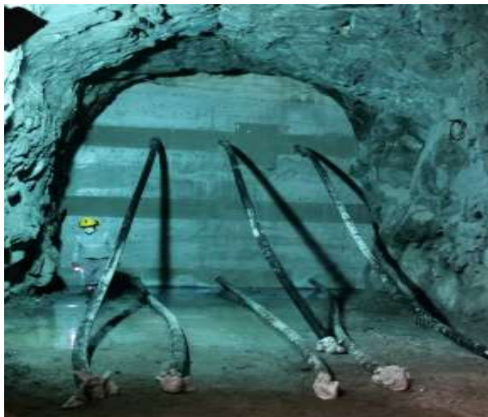
Figura 12: Vista de tapón de Concreto Armado
