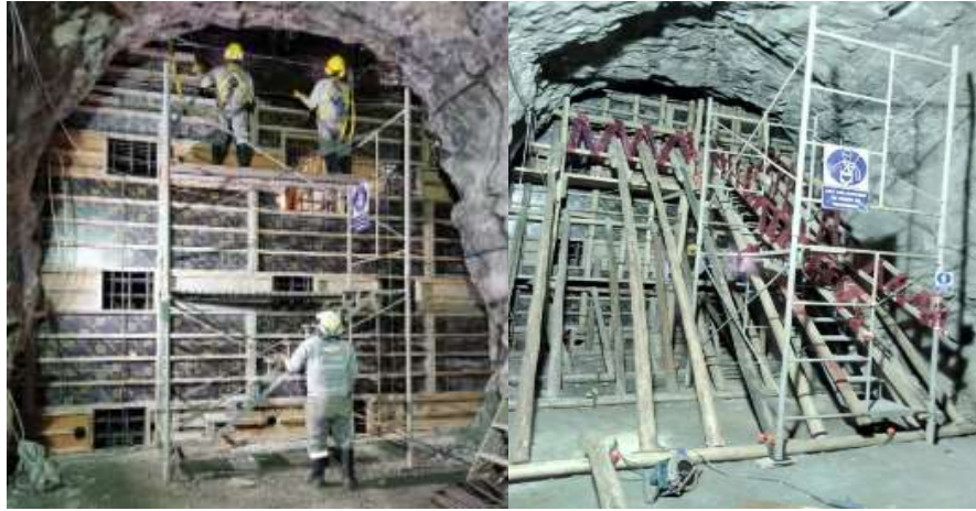
Figura 10: Encofrado y desencofrado de Tapón.
