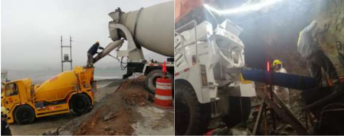
Figura 11: Traslado de concreto premezclado a pie de obra
