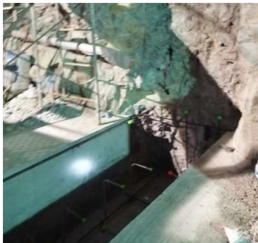
Figura 8: Base de concreto y solado f'c=300 kg/cm 2
