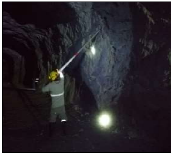
Figura 6 Desate de roca en hastiales
