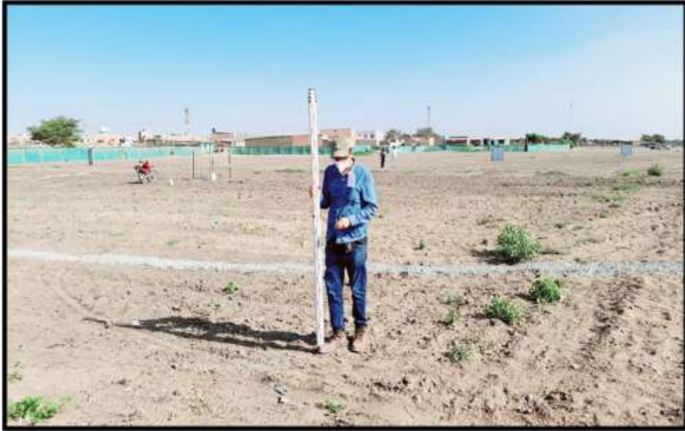
TOMA 03: En esta toma se aprecia trabajo de posicionamiento de la mira para la toma de lectura de cotas de buzones.
