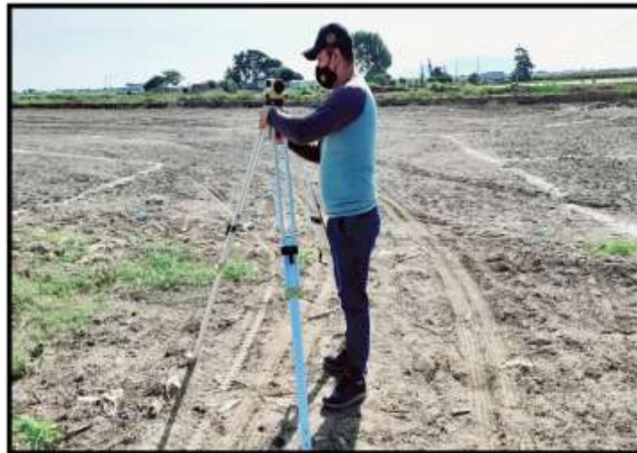
TOMA 02: En esta toma se aprecia trabajo de estacionamiento de Nivel.
