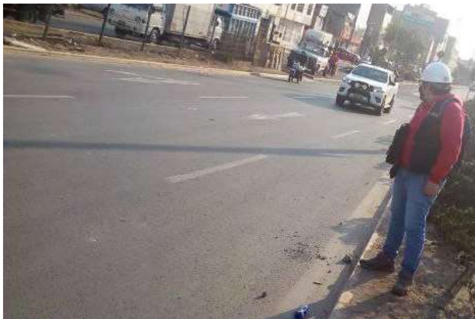
Figura 5. Visualización del pavimento flexible en la Av. 2 de Octubre. Fuente: Propia.
