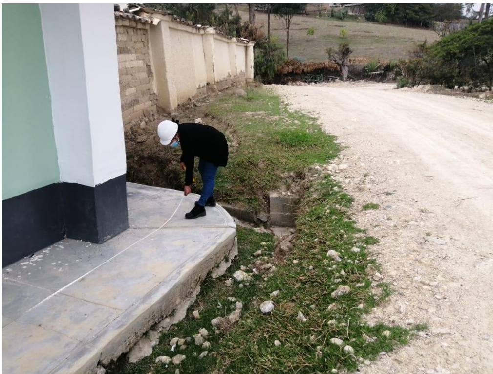
Fotografía 2: Toma de medidas de la infraestructura de la institución educativa Mariavilca 82096.
