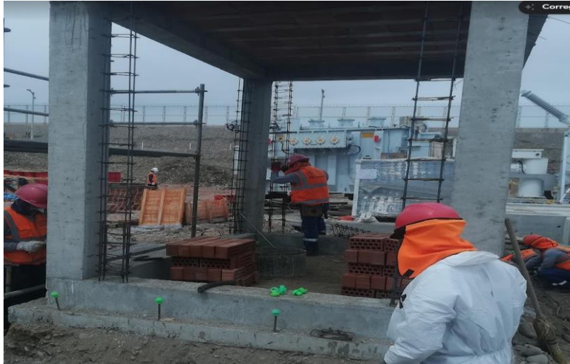
Figura 3. Aplicación de concreto en vigas y columnas
