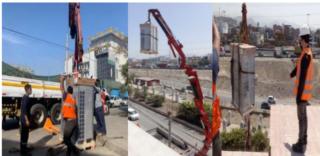
Figura 29. Proceso de izaje de las unidades condensadoras.
