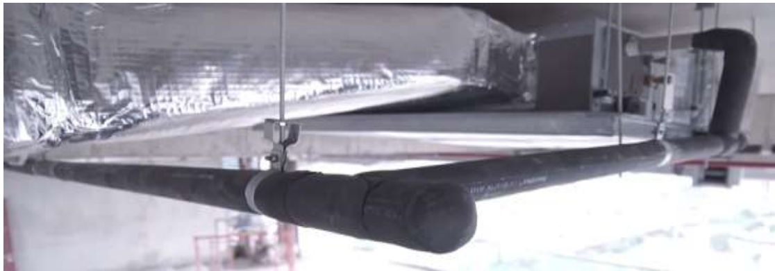
Figura 37. Proceso de montaje e instalación del sistema de drenaje.
