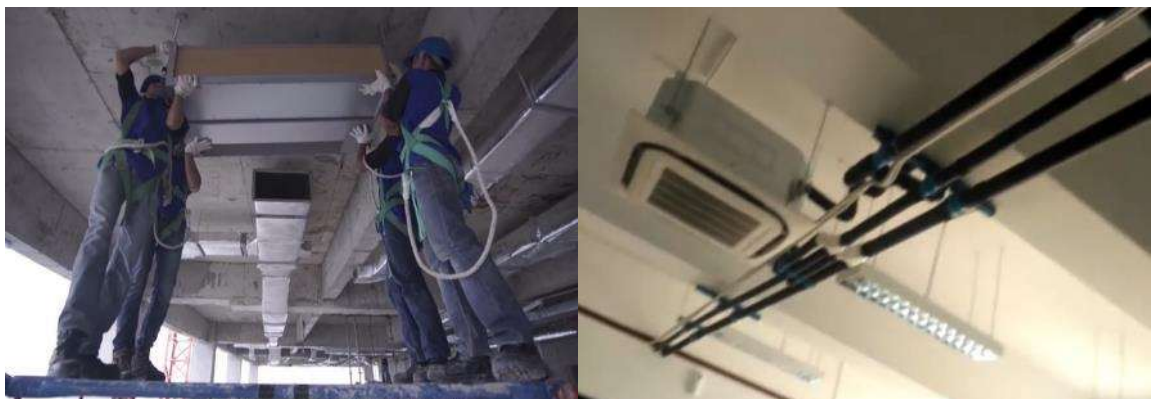
Figura 32. Montaje de un evaporador tipo fan coil y tipo cassette.
