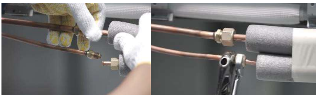
Figura 39. Proceso de implementación final de todo el sistema de tuberías de refrigeración.
