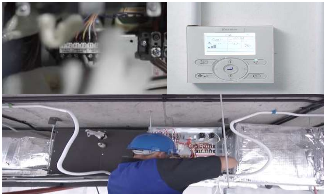
Figura 38. Proceso de canalizar, cablear y conexas los sistemas de fuerza y control.
