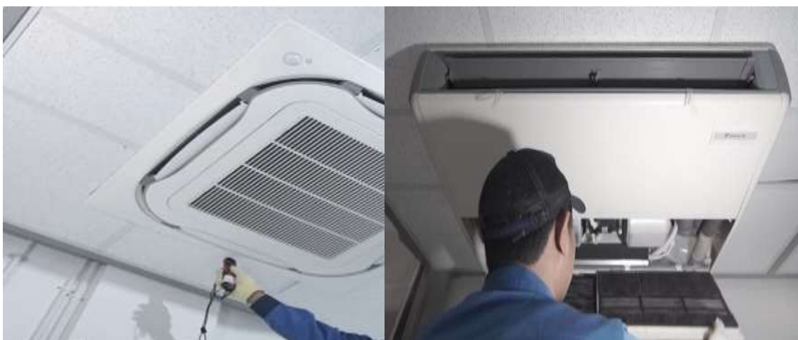
Figura 44. Verificación de los parámetros de funcionamiento.
