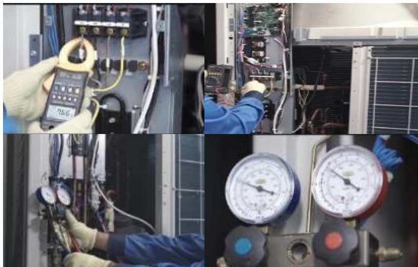
Figura 43. Energización del equipo y pruebas pre operacionales y operacionales.
