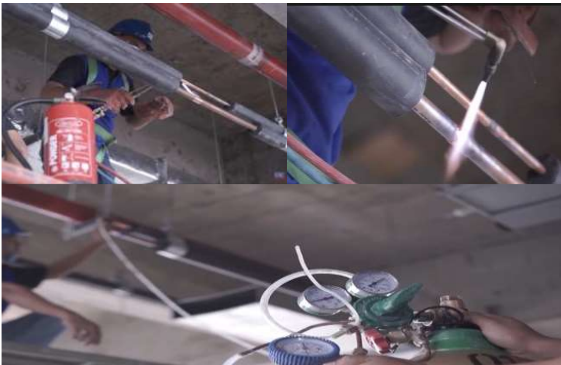
Figura 35-Proceso de soldadura oxi acetilénica en cada unión, codo o Banch.
