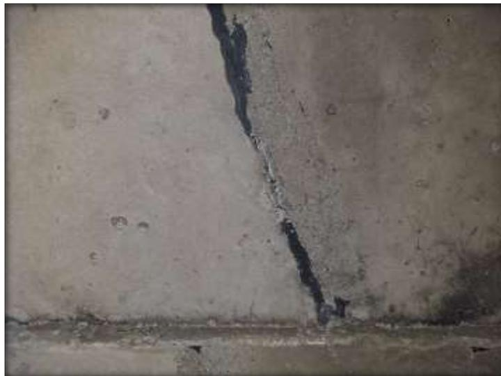
*Figura 30. Vista de la Junta de Construcción con Puente de Adherencia*
