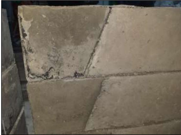
**Foto N° 12:** En la fotografía se observa la junta de construcción sin puente de adherencia en la viga.
