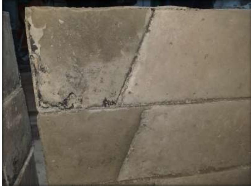
*Figura 31. Vistas de la Junta de Construcción sin Punte de Adherencia*
