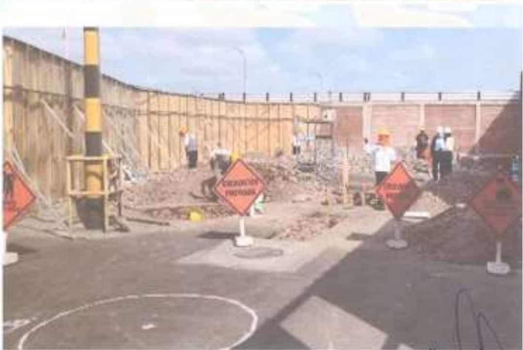
EXCAVACIÓN DE LOS POZOS PRECOLADORES
