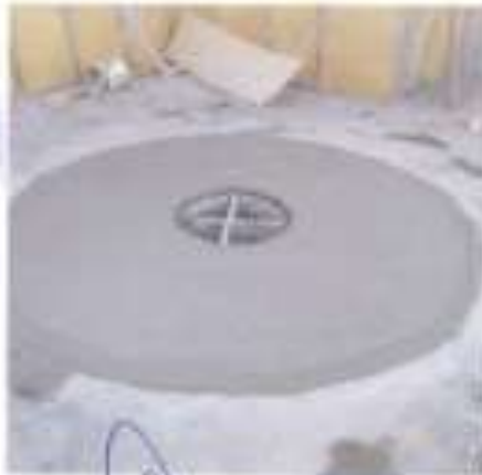
VACIADO Y VIBRACION DE CONCRETO FC 210KG/CM 2
