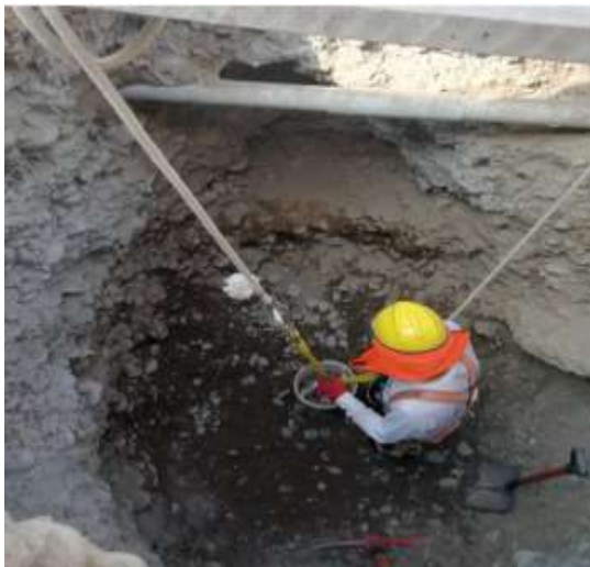
Figura 31. Excavación de zanja para pozos percolador.
