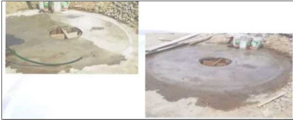
Figura 35. Curado de tapas de pozos percoladores.
