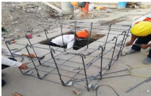
Figura 40. Armado de acero para la caja de registro.
