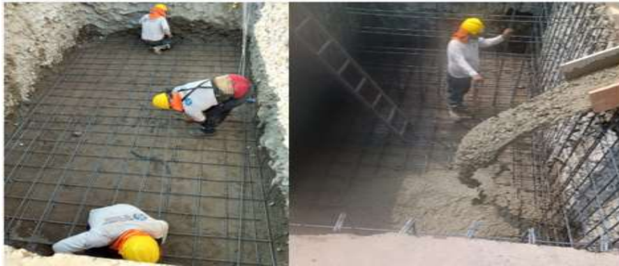
Figura 26. Armado de acero longitudinal y vertical tanque séptico.
