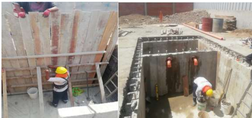
Figura 27. Encofrado y desencofrado del tanque séptico.
