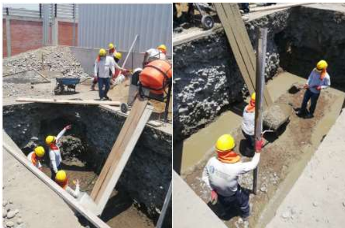
Figura 25. Vaciado del solado.
