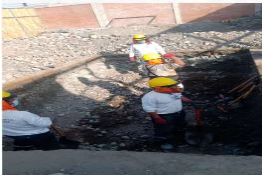
Figura 23. Excavación de zanja tanque séptico.
