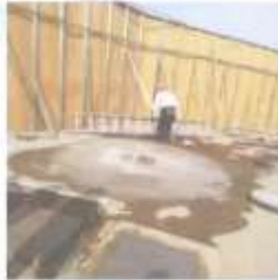
CURADO DE LAS TAPAS DE POZOS PERCOLADORES Nº3 Y Nº4
