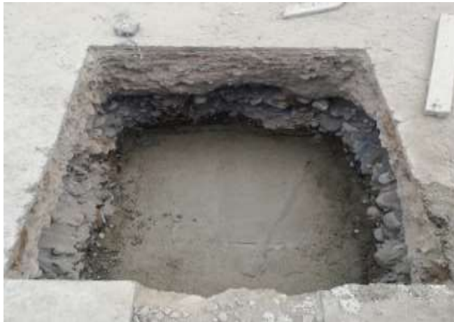
Figura 39. Vaciado del solado de la caja de registro.
