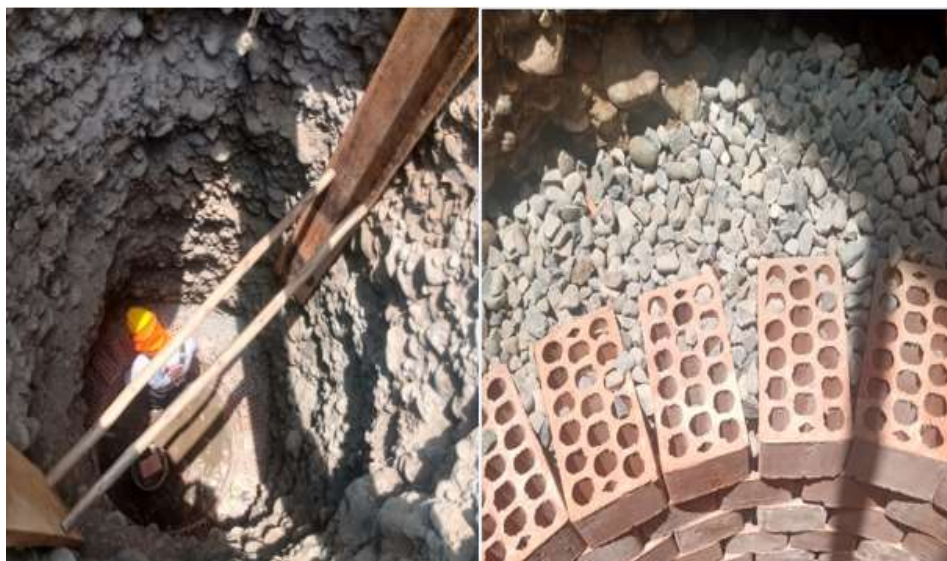
Figura 36. Asentado de ladrillo y colocación de grava en pozos percoladores.
