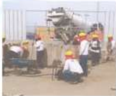
VACIADO Y VIBRACION DE CONCRETO FC 210KG/CM 2
