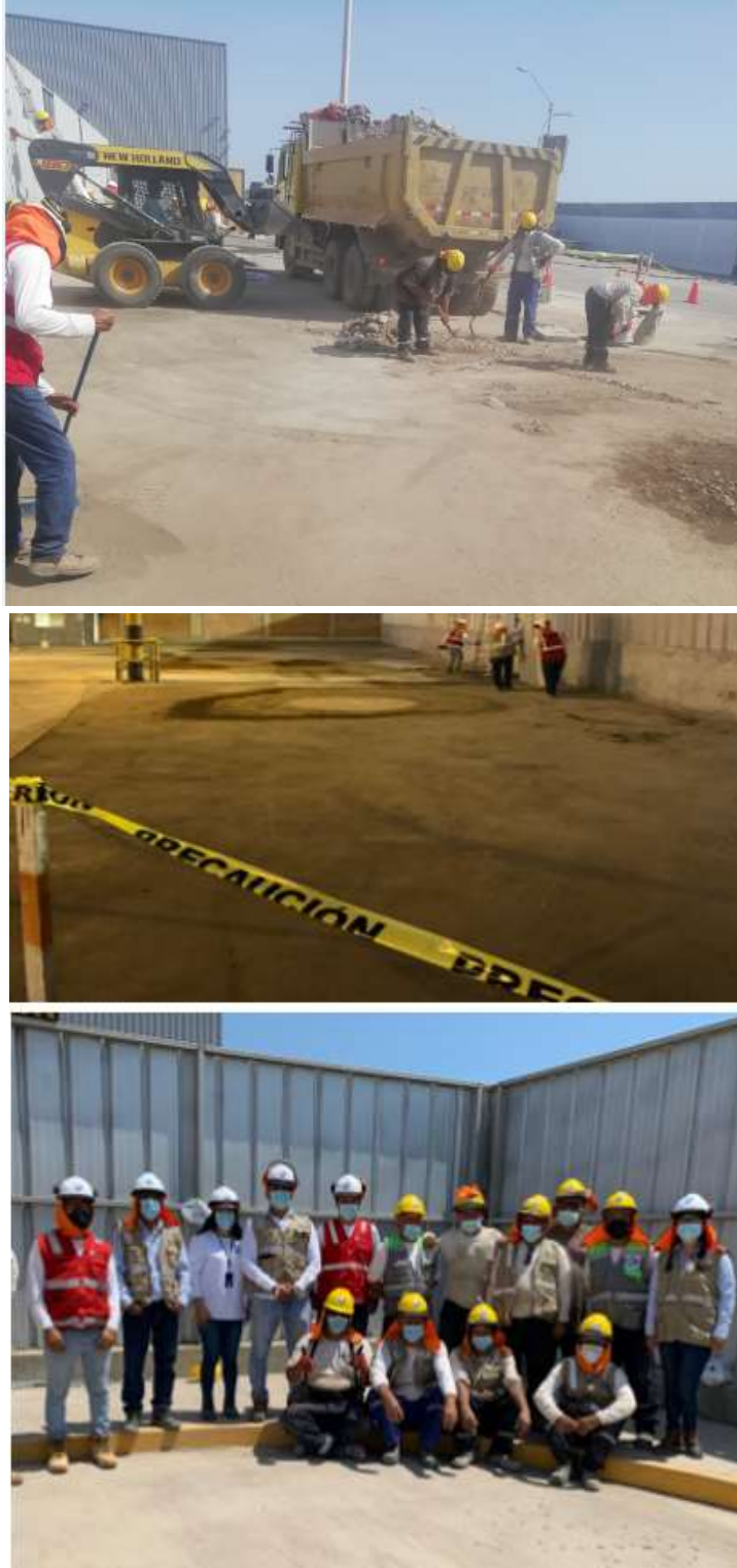
Figura 43. Limpieza final de obra.
