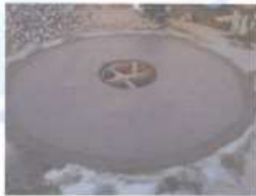
VACIADO DE CONCRETO FC 210KG/CM 2 PARA LOS POZOS PERCOLADORES
