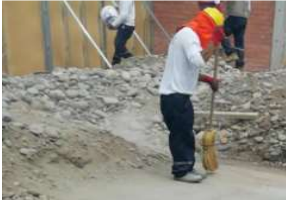
Figura 30. Limpieza de obra.
