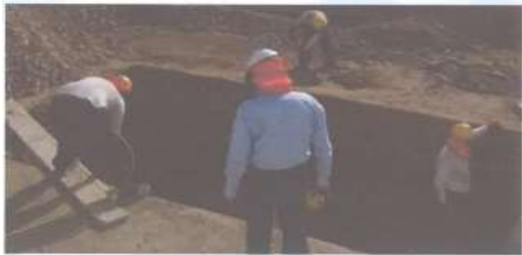
EXCAVACION DEL TANQUE SEPTICO.
