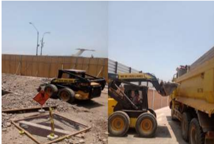
Figura 24. Eliminación de material excedente.
