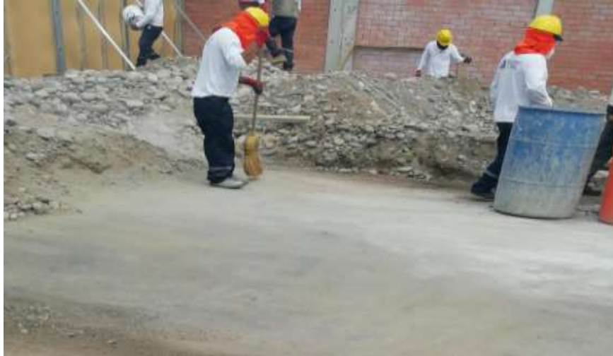
Figura 22. Limpieza de obra.
