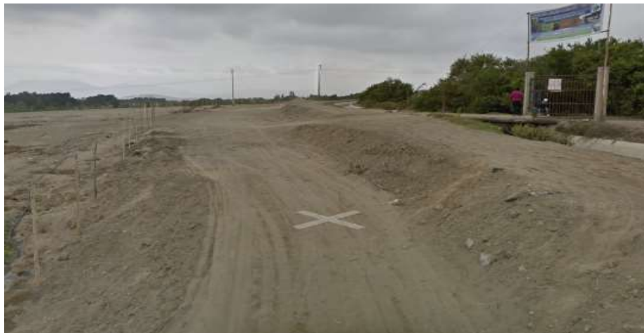
Figura 34. Vista a calle sin nombre
