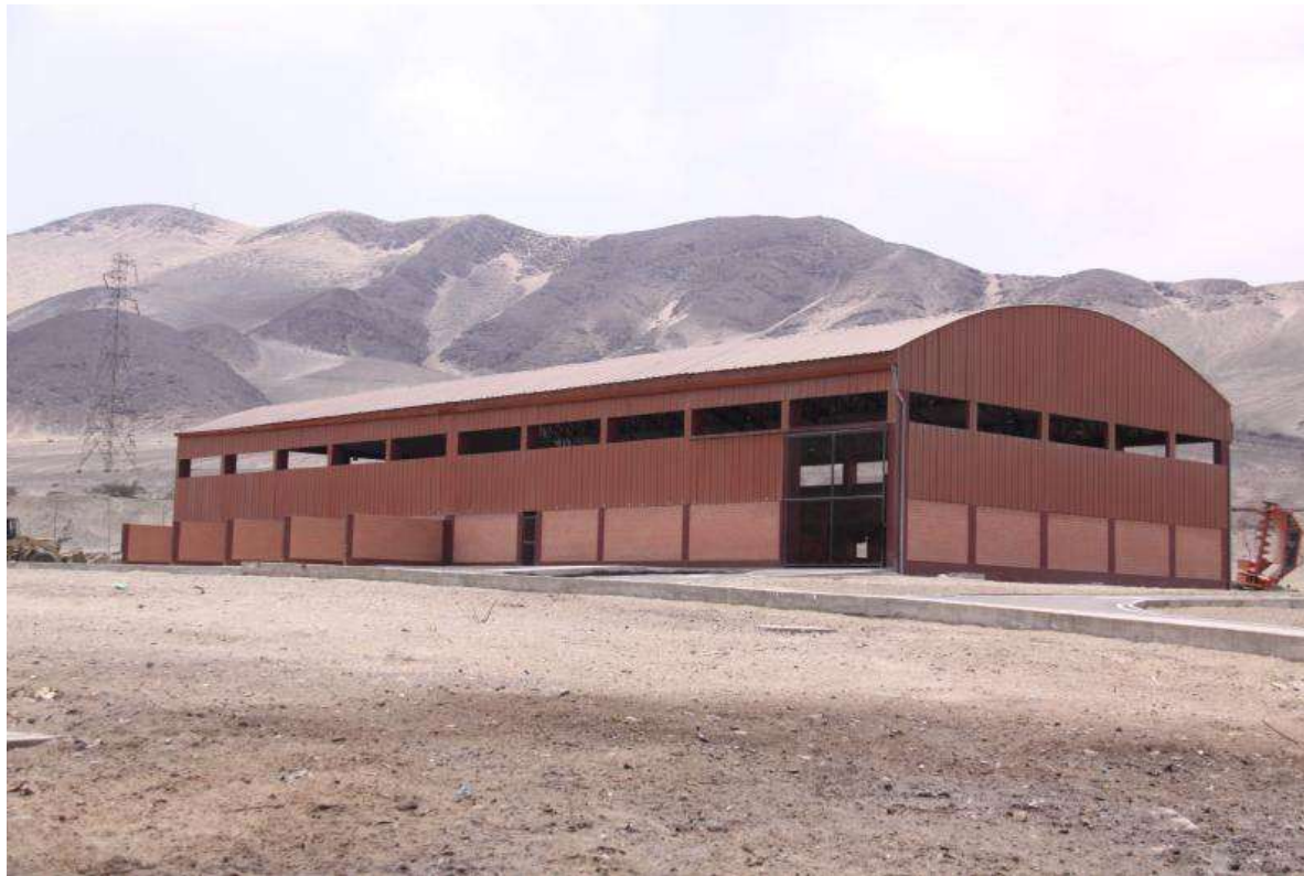
Figura 85. Actual Planta de Tratamiento de Chimbote Fuente: Google imágenes
