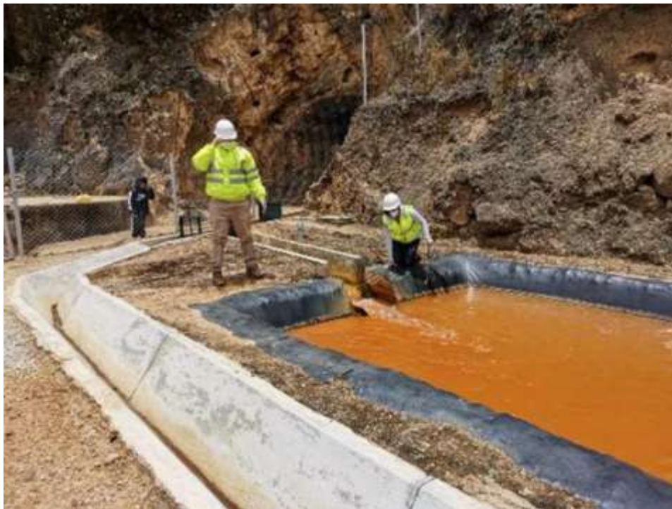
Foto 4. Poza de descarga del DAM de la bocamina San Luis
