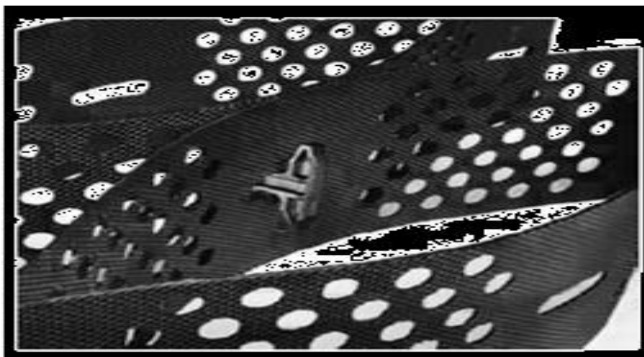
Ilustración 7: Engrapado de geoceldas
