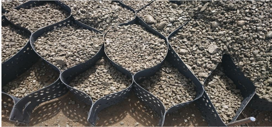
Ilustración 5: Geocelda en proceso de llenado
