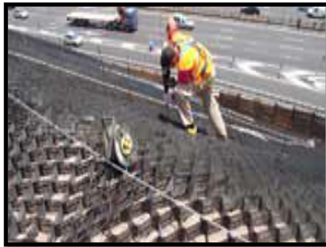
Ilustración 3: Colocación del Geo sintético DLT Geocelda Step
