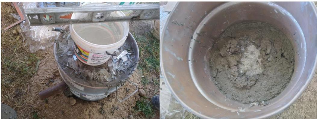
*Ilustración 16: Construcción del horno para la fusión de concentrados de oro, se puede apreciar el vaciado del concreto mezclado con el vidrio molido.*
