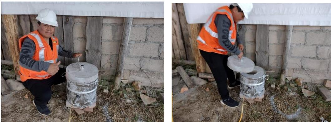
*Ilustración 18: Construcción del horno para la fusión de concentrados de oro, se puede apreciar el horno después de vaciado y fraguado el concreto.*
