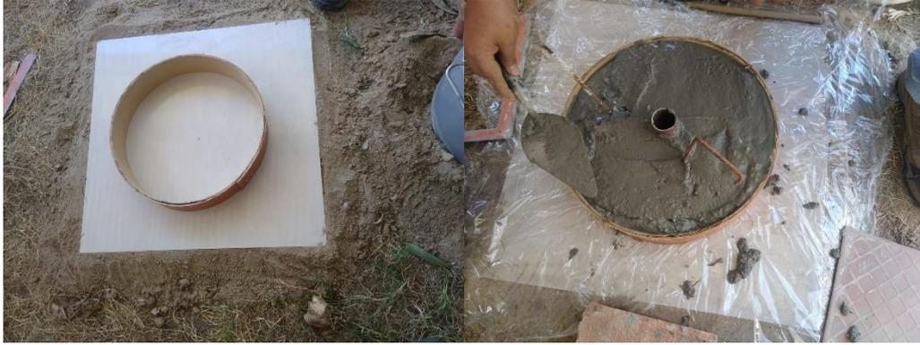
*Ilustración 17: Construcción del horno para la fusión de concentrados de oro, se puede apreciar el vaciado del concreto para la fabricación de la tapa.*
