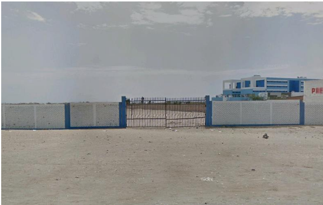
FUENTE: GOOGLE EARTH – IMAGEN DEL TERRENO
