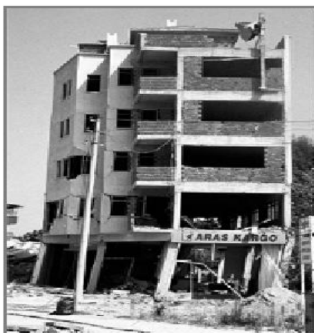
Figura 11. Dirección poco resistente a fuerza lateral (Sezen, et al 2003)
