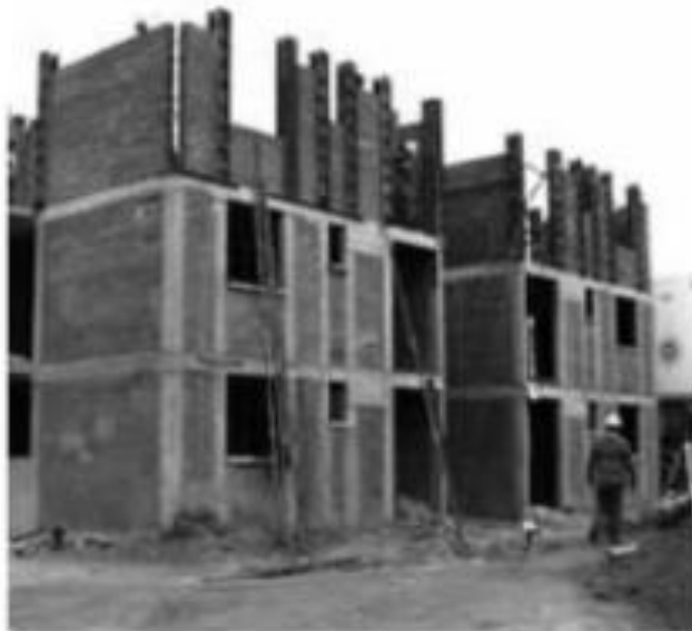
Figura 6. Vivienda de Albañilería Confinada. (San Bartolomé, 2019).
