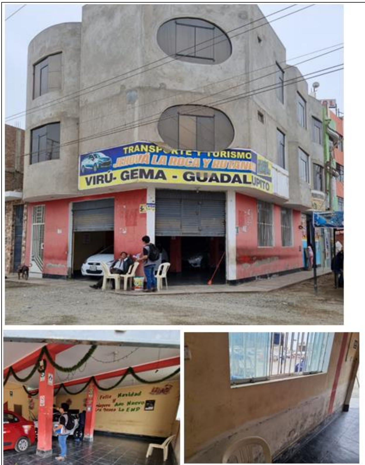
Figura 88. Edificación N°03 y patologías.
