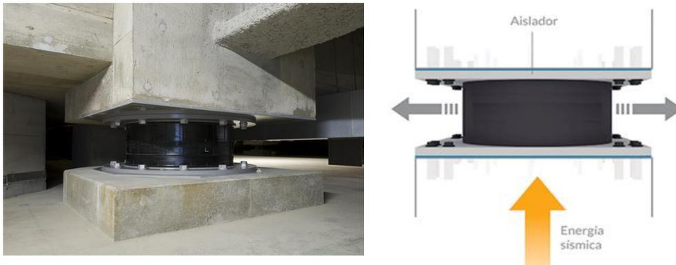
Figura 3.- Aislador sísmico HDR - Fuente: CDV – Ingeniería Sísmica.
