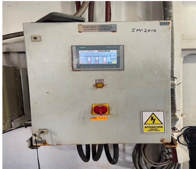
Figura 52 Cableado y puesto en marcha el equipo Fuente: elaboración propia
