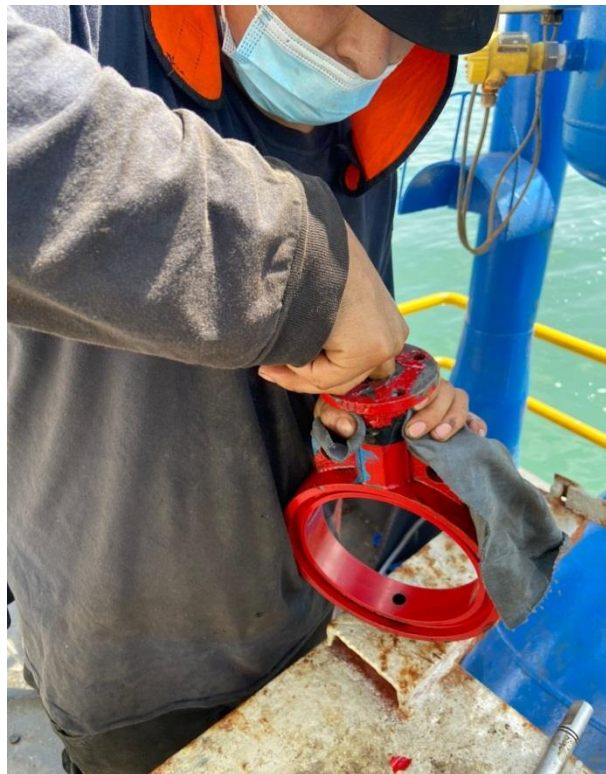
Figura 53 Mantenimiento de la válvula mariposa y cambio de asiento Fuente: elaboración propia
