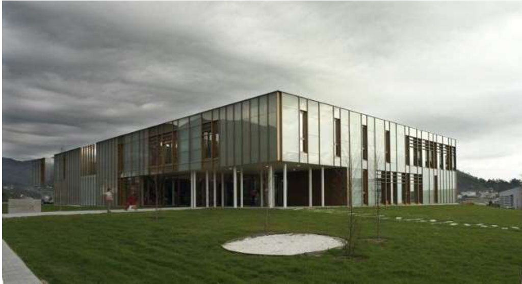
Figura N°23: Vista del Centro de Salud Física Infantil Muros
