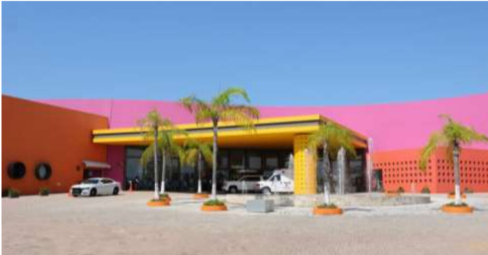
Figura N°19: Ingreso al Centro de Rehabilitación Infantil Teletón CRIT
