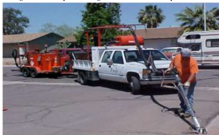
Figura 7. Limpieza de grieta con aire comprimido
