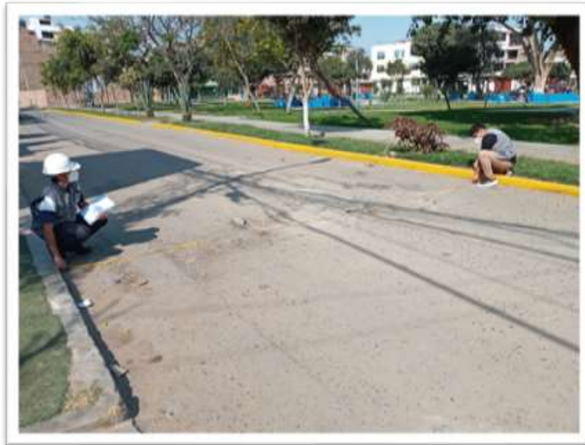
Figura 81. Falla grieta de borde.
