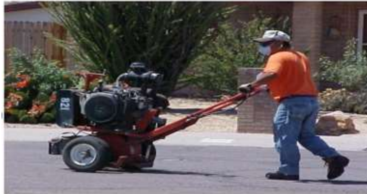
Figura 6. Ruteado de Grieta
