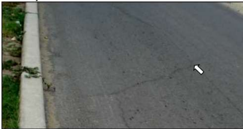
Figura 25. Grietas Parabólicas
