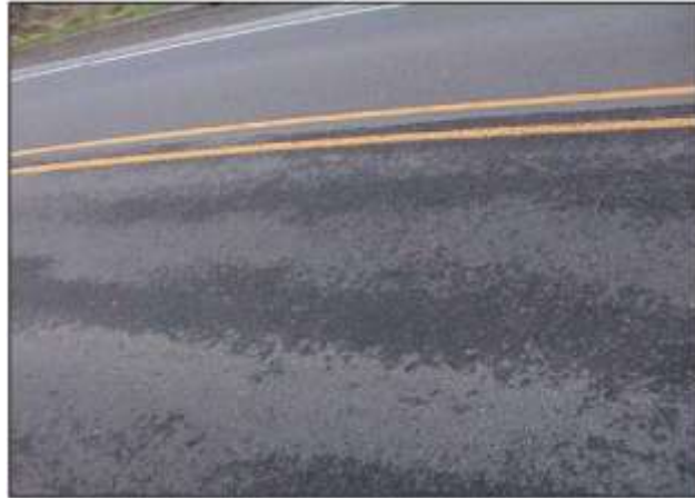
Figura 10. Pavimento con Exudación
