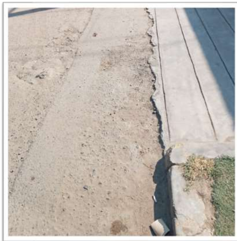
Figura 81. Falla grieta de borde.
