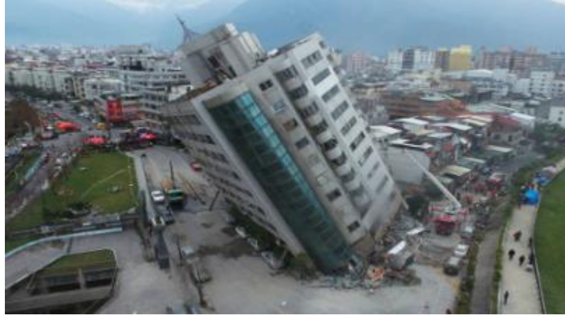
Figura 5: Colapso de edificio en Taiwán por licuefacción.
