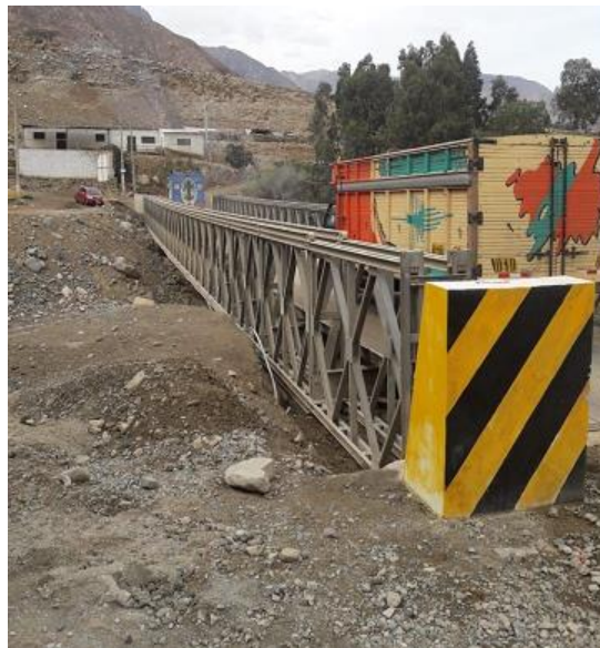
Figura 1. Estado actual del puente la cabaña (un solo carril tipo Bailey).
