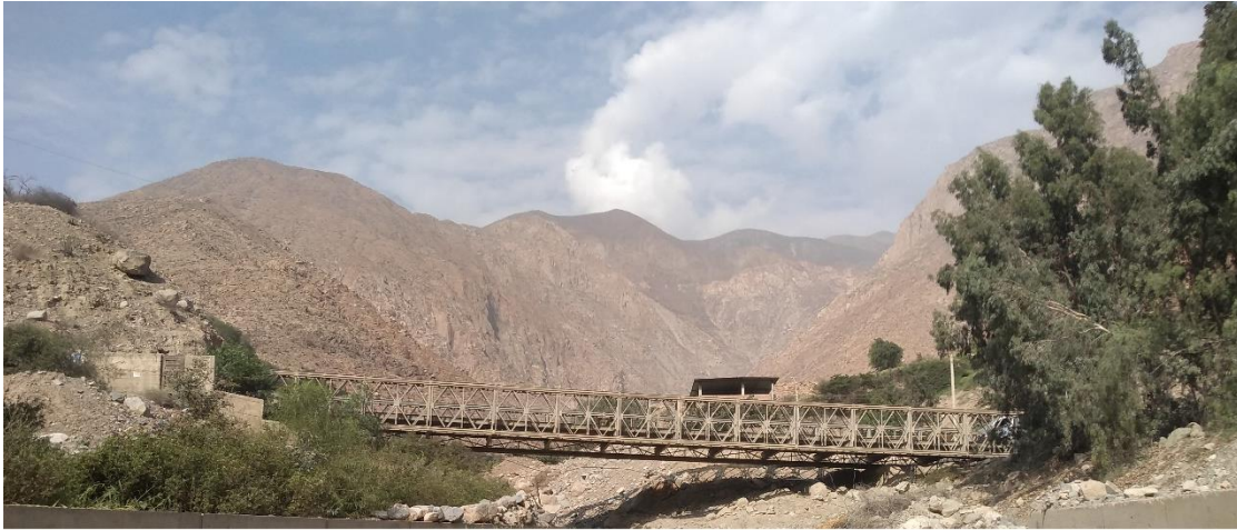
Figura 17. Vista del terreno bajo el puente La Cabaña.
