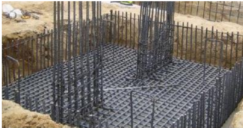
Armadura de acero de refuerzo de zapatas combinadas
