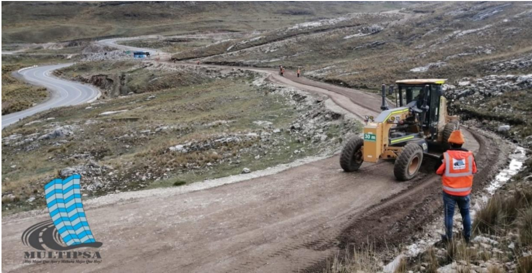
Figura 3. Mantenimiento de carretera de tramo km 106.
