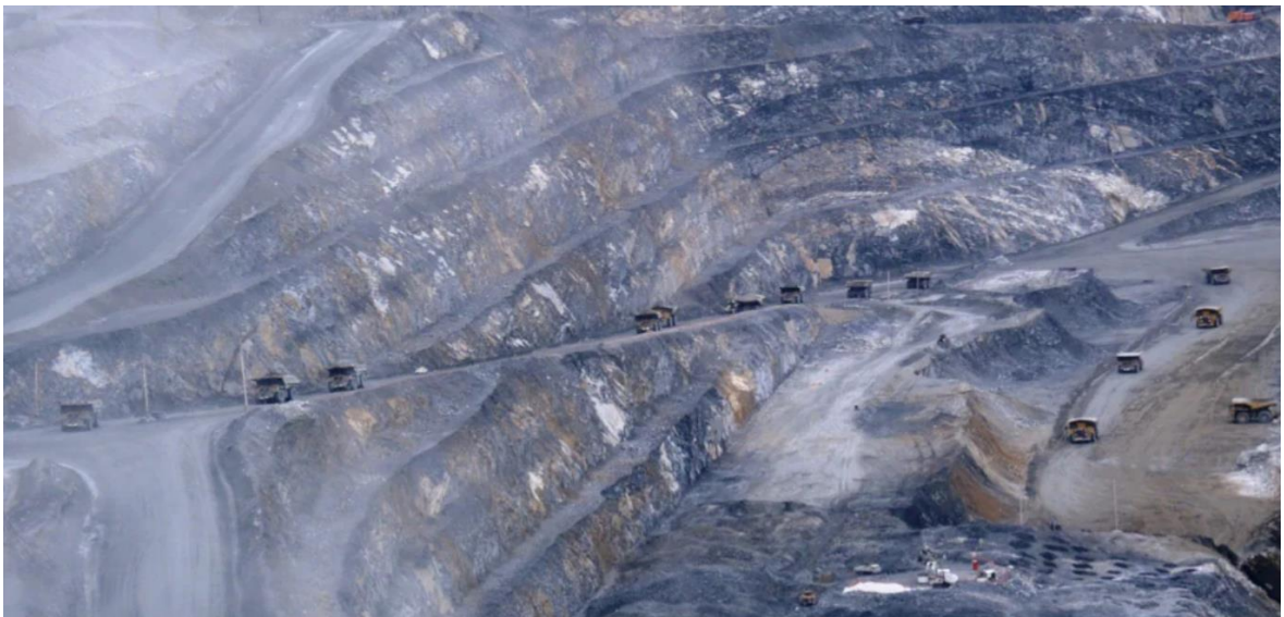
Figura 17 Acarreo de Material en la Unidad minera Antamina – Tajo Abierto Fuente: Antamina
