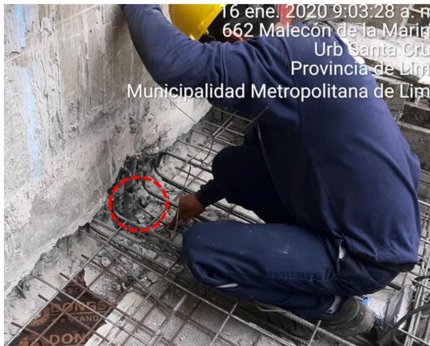
***Figura n.° 9. Reprocesos por falta de supervisión en el vaciado de losa.***
