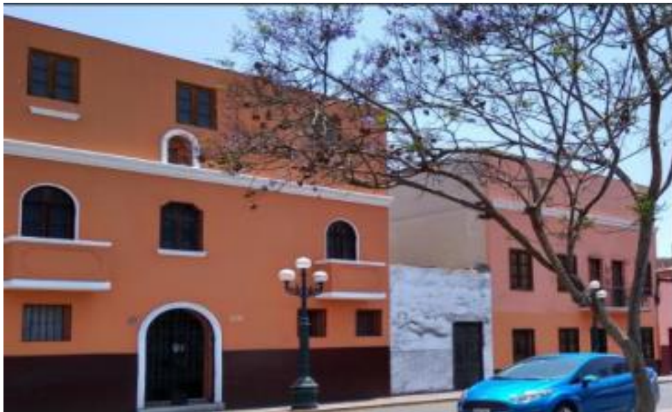
Figura 52: Viviendas en la Av. San Martín (S – N).
