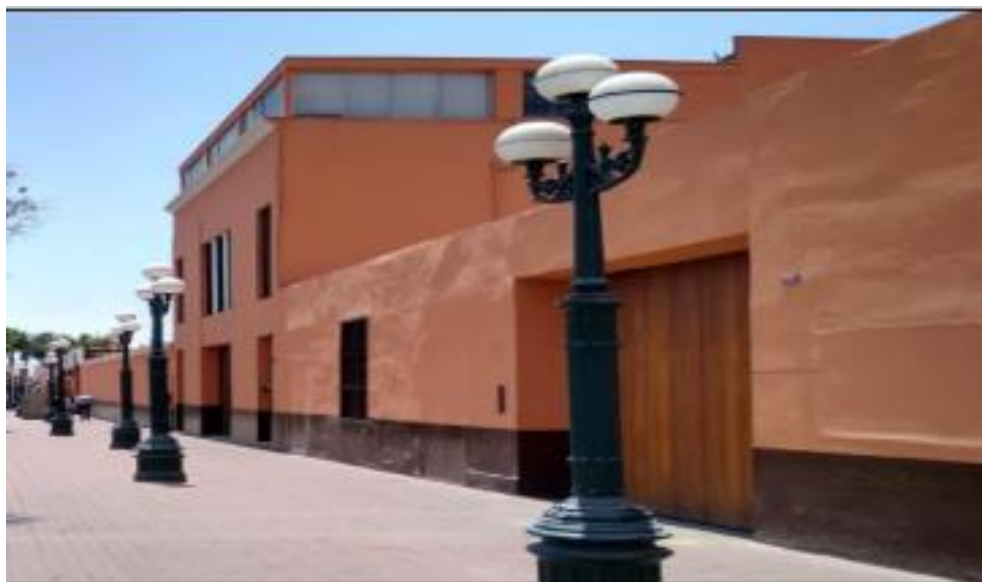
Figura 53: Viviendas en la Av. San Martín (S – N).
