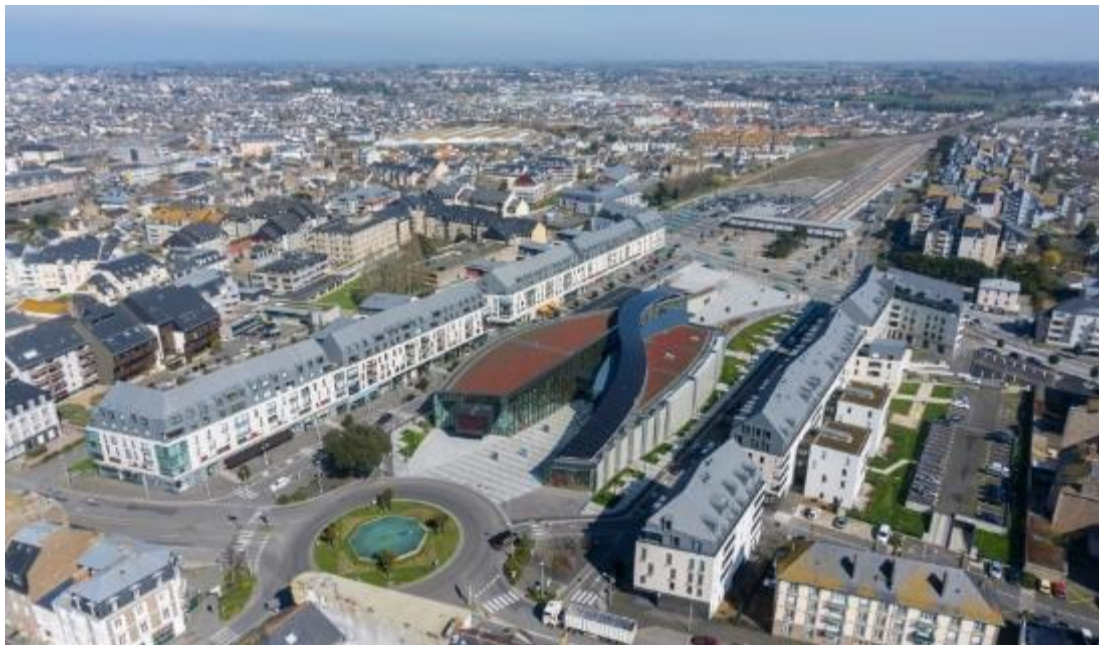
Figura N° 4: Imagen exterior a vuelo de pájaro del Centro Cultural
