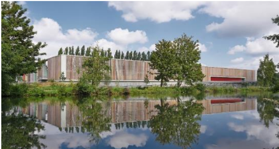
Figura N° 6: Imagen exterior del Centro Acuático
