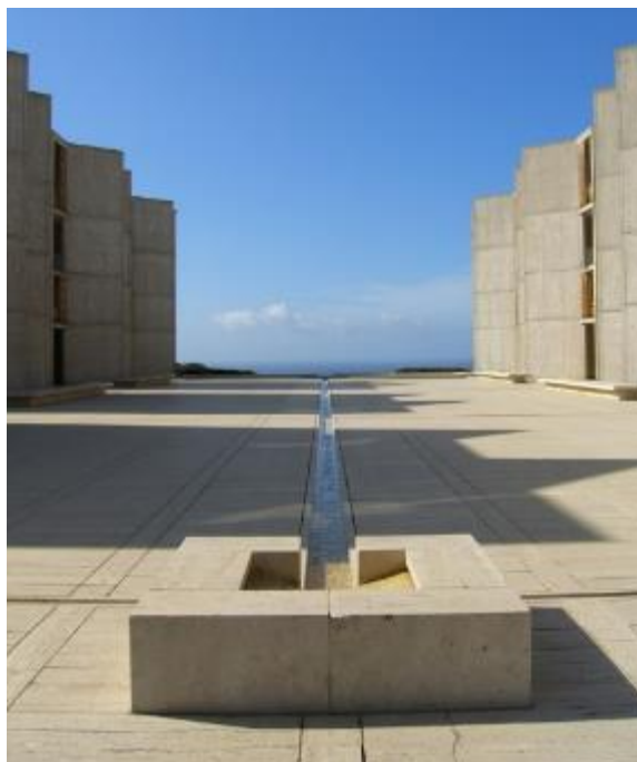
Figura N° 2: Imagen del patio central con vista direccionada hacia el mar
