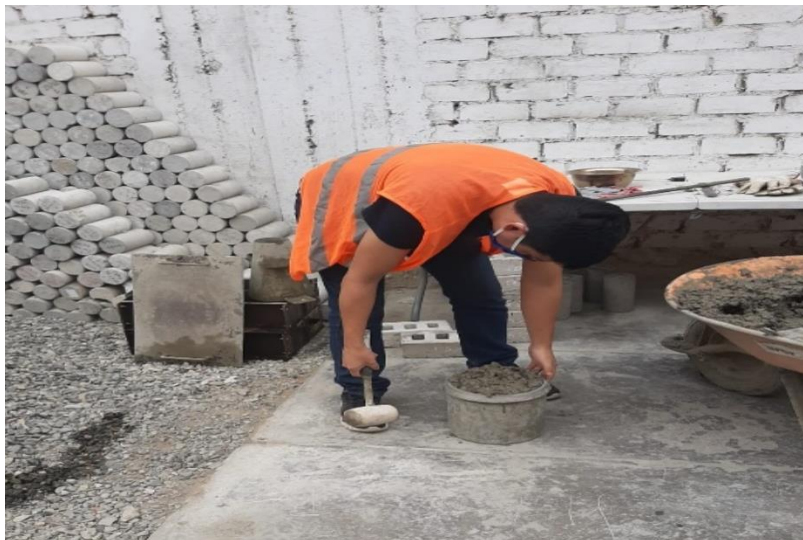
Fotografía 8: Compactación y golpeo con el martillo del concreto fresco con fibras de polipropileno con dosificación de 300 \text{ gr/cm}^3 .
