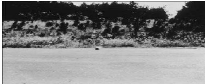
Fig. C.18: Ejemplo de Hinchamiento. El nivel de severidad depende del criterio de la calidad de tránsito.
