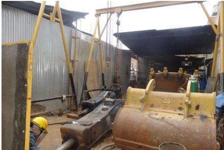
Figura 15 Vista frontal de taller- Falta de señalización
