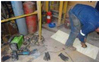
Figura 12 Trabajo de corte con amoladora
