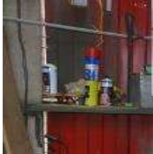
Pintura sin rotulado, sin tarjeta HMIS III.
