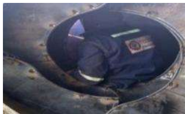
Figura 9 Soldadura de componentes
