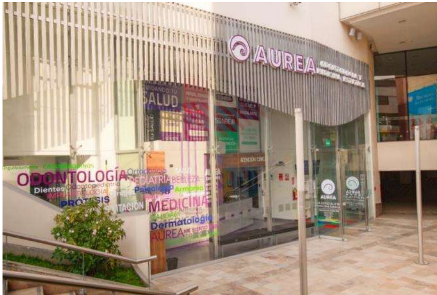
Figura 1 Fachada principal del centro médico Aurea Implant
