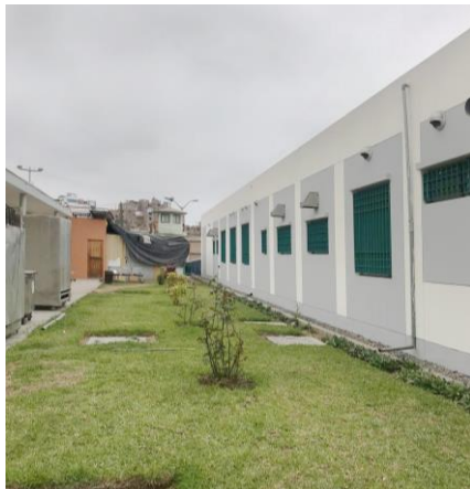
Patio Exterior INR
