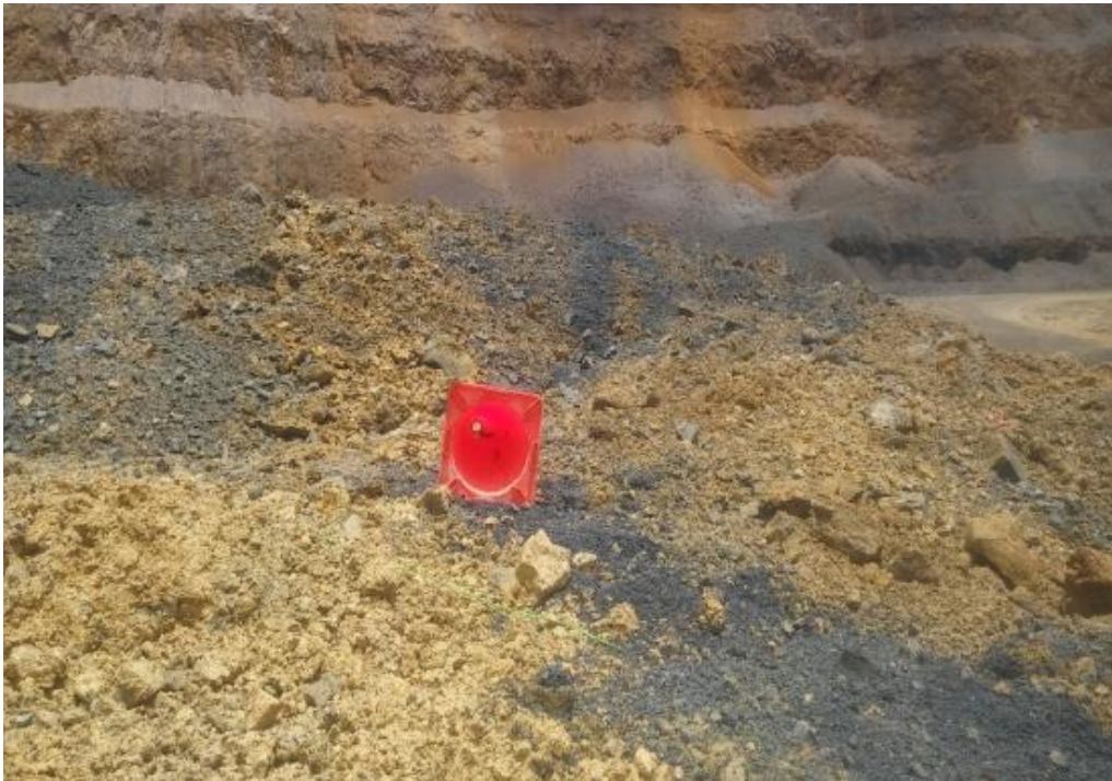
Voladura N°3, densidad 1.10
