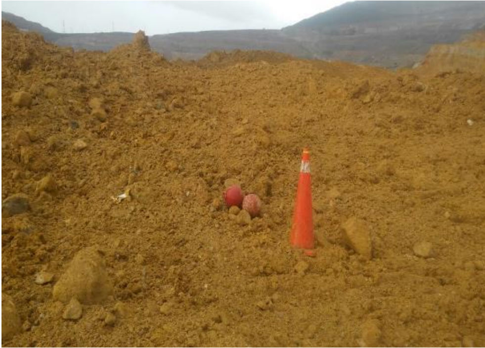
Voladura N°3, densidad 1.10
