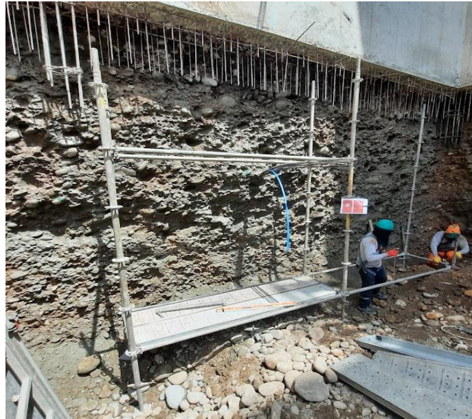
Figura 36. Correcto procedimiento de armado de andamio
