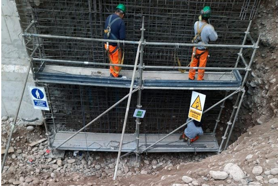
Figura 18. Correcto armado y liberación del andamio
