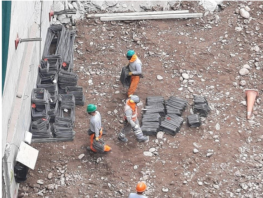
Figura 40. Orden y limpieza
