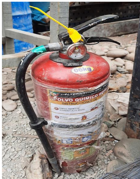
Figura 23. Inspección de extintor
