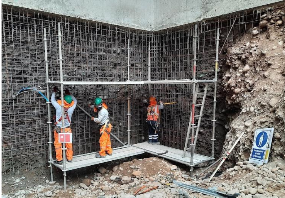
Figura 38. Correcto procedimiento de desarmado de andamio
