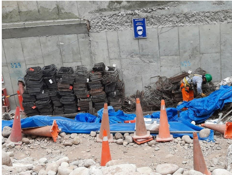
Figura 34. Orden y limpieza
