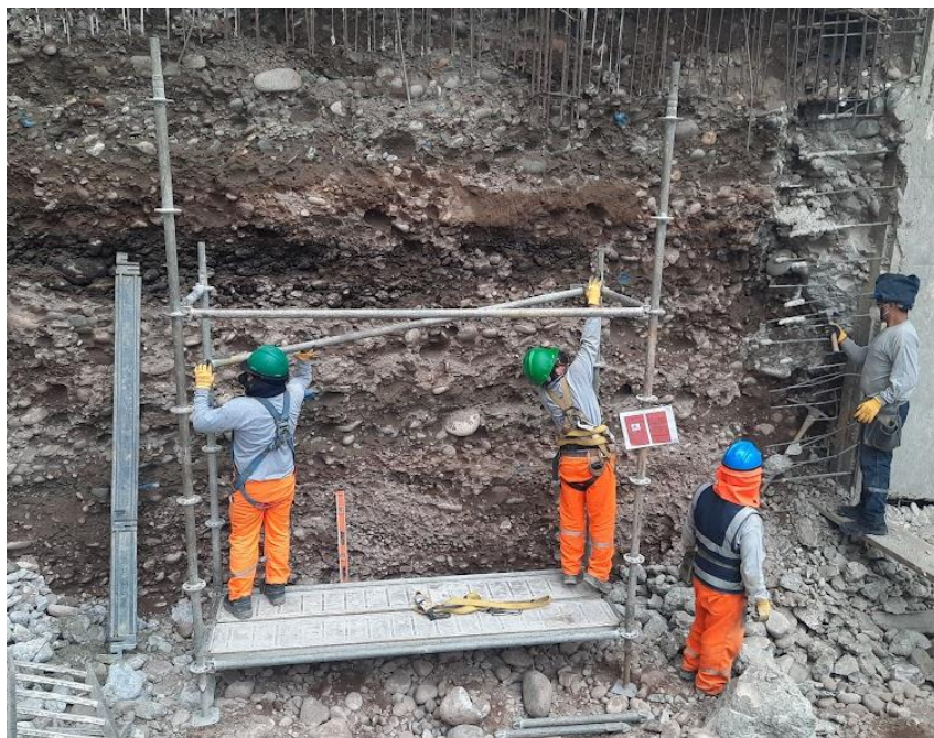
Figura 35. Correcto procedimiento de armado de andamio
