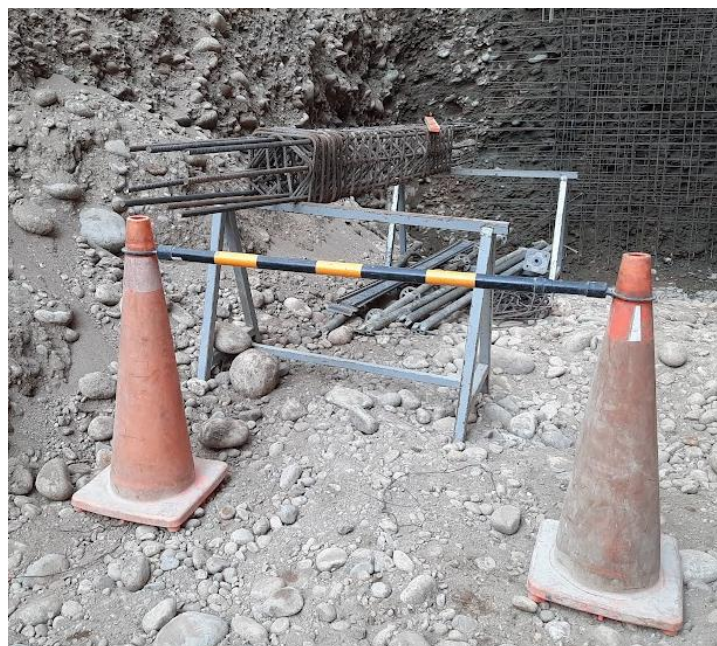
Figura 37. Señalización de materiales
