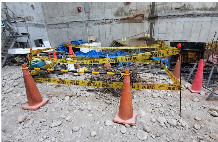
Figura 47. Señalización de acopio de desperdicios de material
