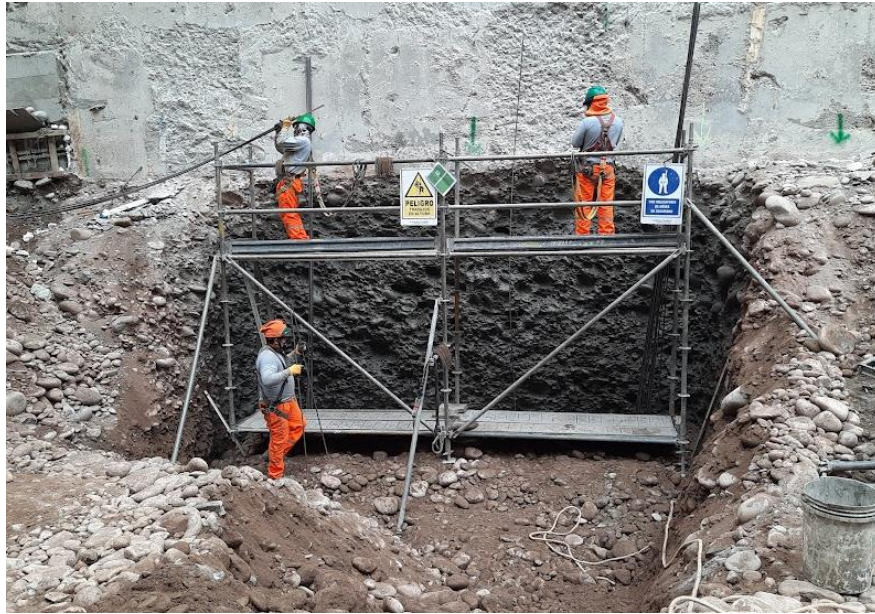
Figura 28. Correcto armado de andamio
