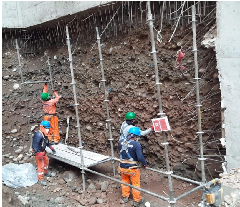
Figura 46. Correcto procedimiento de armado de andamio
